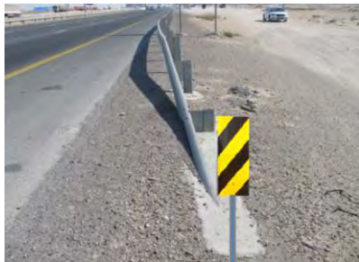
ب: بالای شکل کردن قسمت ابتدایی گاردریل
