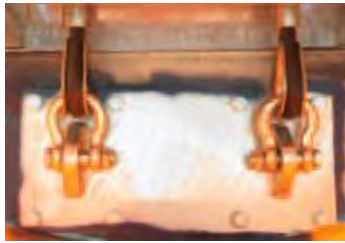
۳-۴۸- نصب صفحه و بولت بر روی میل‌مه‌ار
