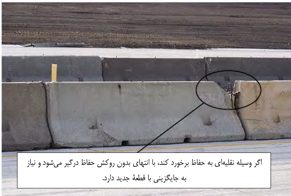
تصویر ۴۲: نمونه‌ای از آسیب دیدگی حفاظ بتنی که باید قطعه تعویض شود
