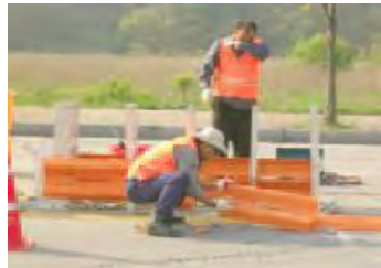
۶-۴۸- نصب دیواره‌ی ضربه‌گیر
