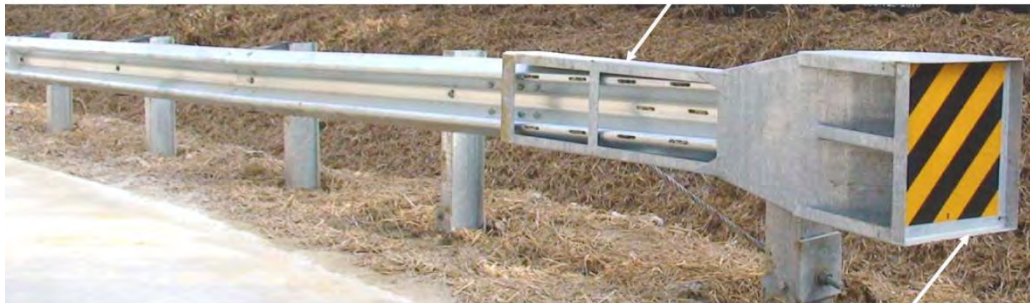
سر ضربه‌پذیر سرسپری (اشکار شده با شیرنگ)
