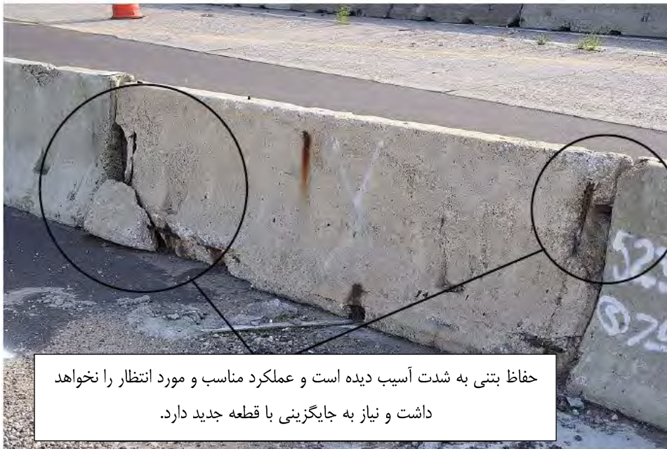
تصویر ۴۱: نمونه‌ای از آسیب دیدگی حفاظ بتنی که باید قطعه تعویض شود
