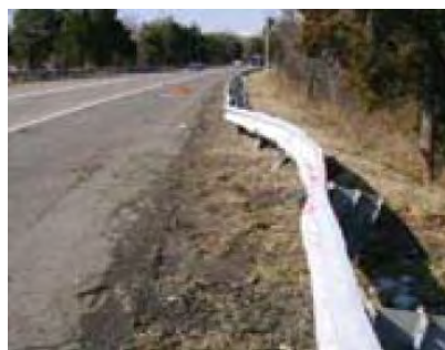
ج: خم شدن و عقب رفتن حفاظ بیشتر از حد مجاز یا تخریب بیش از ۳ پایه
