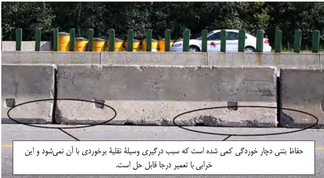
تصویر ۴۰: نمونه‌ای از خوردگی حفاظ بتنی که قابل تعمیر در محل است
