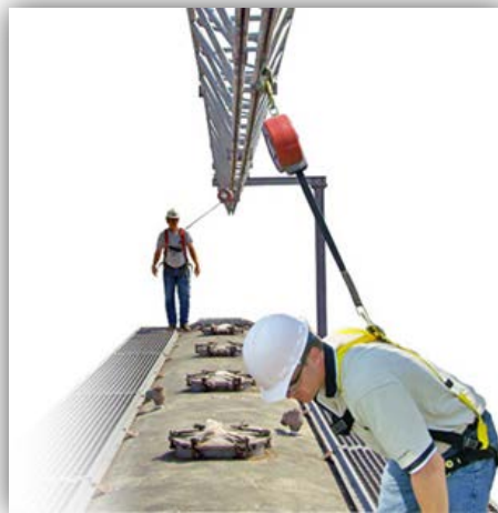
شکل ۲-۱۲- سیستم‌های محافظت از سقوط
