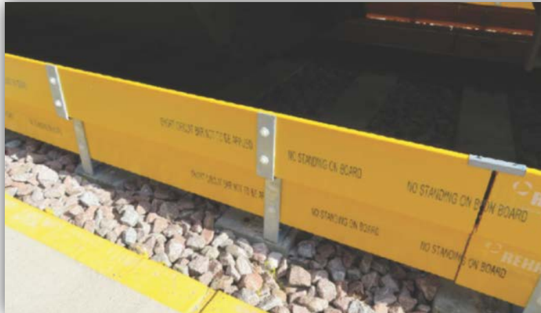
شکل ۴-۲- نمونه ای از مانع دابل پیش‌بینی شده بین پیاده‌رو و ریل سوم
