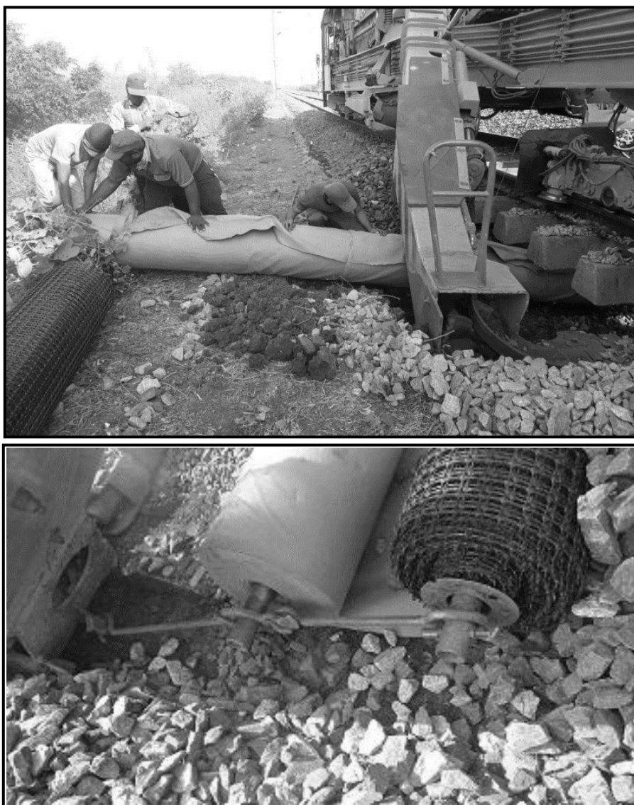
شکل ۱۰-۶- نحوه قرارگیری ژئوتکستایل و ژئوگرید پشت ماشین سرنند بالاست
