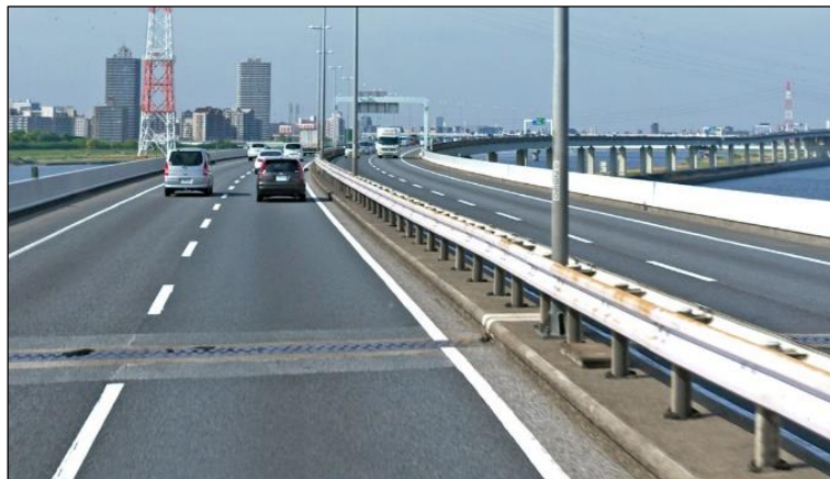
شکل ۴-۵- نمونه میانه با حفاظ طولی نیمه صلب
