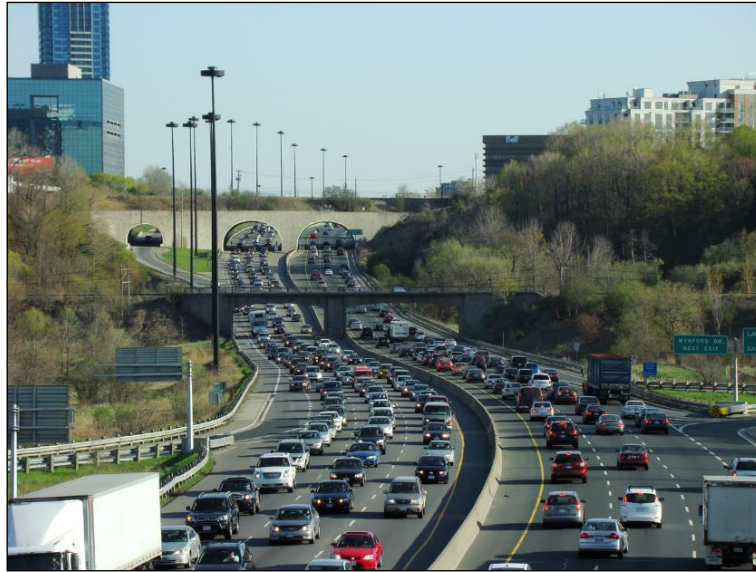
شکل ۴-۴- نمونه میانه با حفاظ طولی صلب
