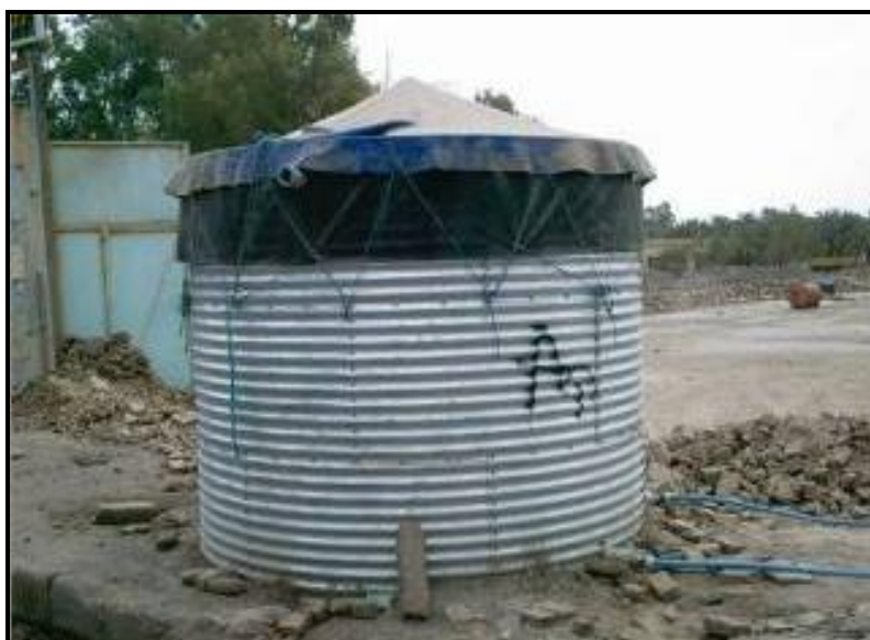
شکل 2-12- نمونه‌ای از مخزن اضطراری آب نصب شده در بم
