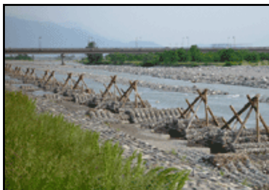
1- تقویت کناره‌های رودخانه‌ها با استفاده از خاکریزی و سنگ‌چینی
