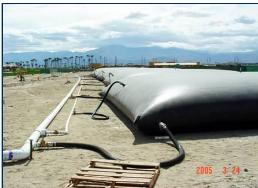
شکل 2-13- نمونه‌ای از مخزن انعطاف‌پذیر در مواقع بحران
