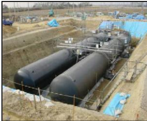
شکل 2-10- مخازن اضطراری آب
