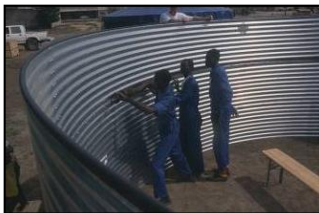
شکل پ. 2-1- نمونه‌ای از نصب مخزن اضطراری آب توسط فدراسیون بین المللی جمعیت‌های صلیب سرخ و هلال احمر در آفریقا
