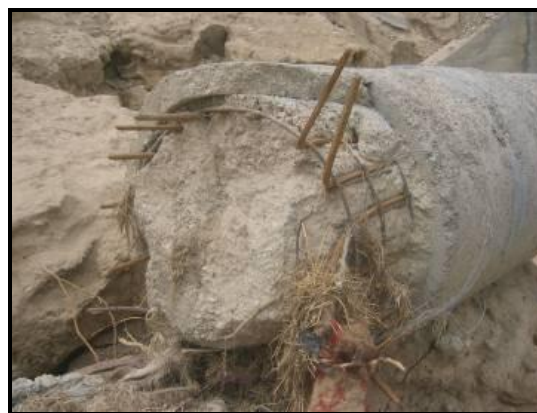
شکل 1-17- تخریب سازه با مشخصات اجرایی نامناسب مجاور رودخانه ساری سو در خلال سیلاب سال 84 [9]
