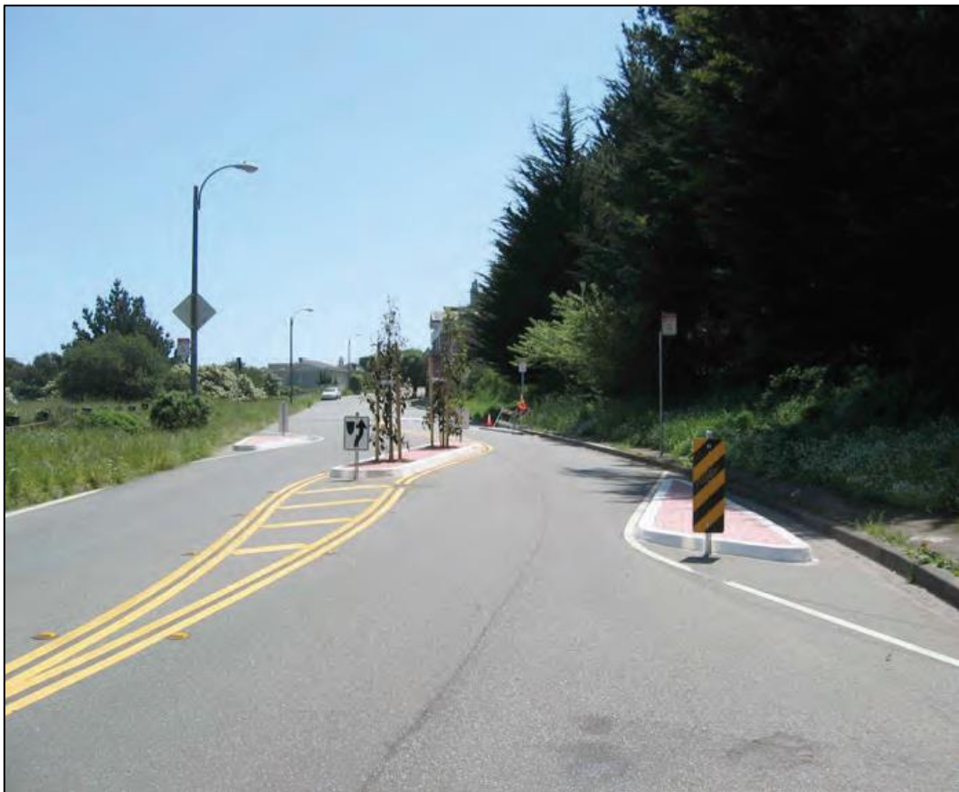
شکل ۹-۲- استفاده از پیکان‌دهنده به منظور آرام‌سازی ترافیک در نواحی تغییر سرعت
