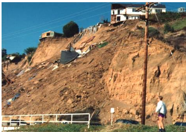
شکل (۳-۷): زمین‌لغزش و تخریب سازه‌های بالا و پایین‌دست شیروانی
