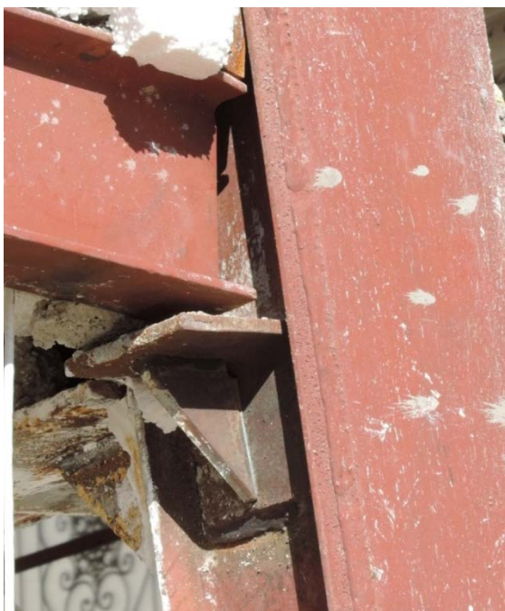
شکل (۴-۲۸): جدا شدن تیر از نبشی نشیمن
