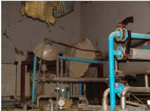
شکل (۴-۸): آسیب وارده به تأسیسات ساختمان ناشی از سقوط
