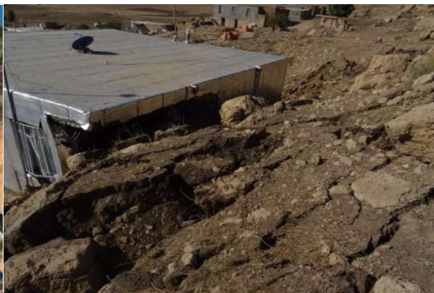
شکل (۳-۷): زمین‌لغزش و تخریب سازه‌های بالا و پایین‌دست شیروانی
