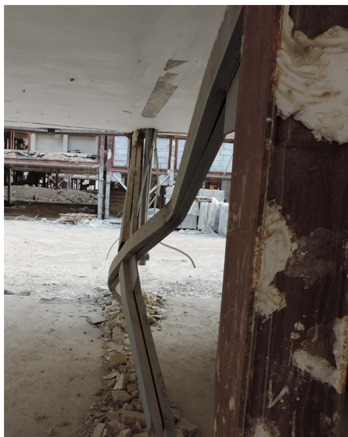
شکل (۴-۱۶): تسلیم مهاربند
