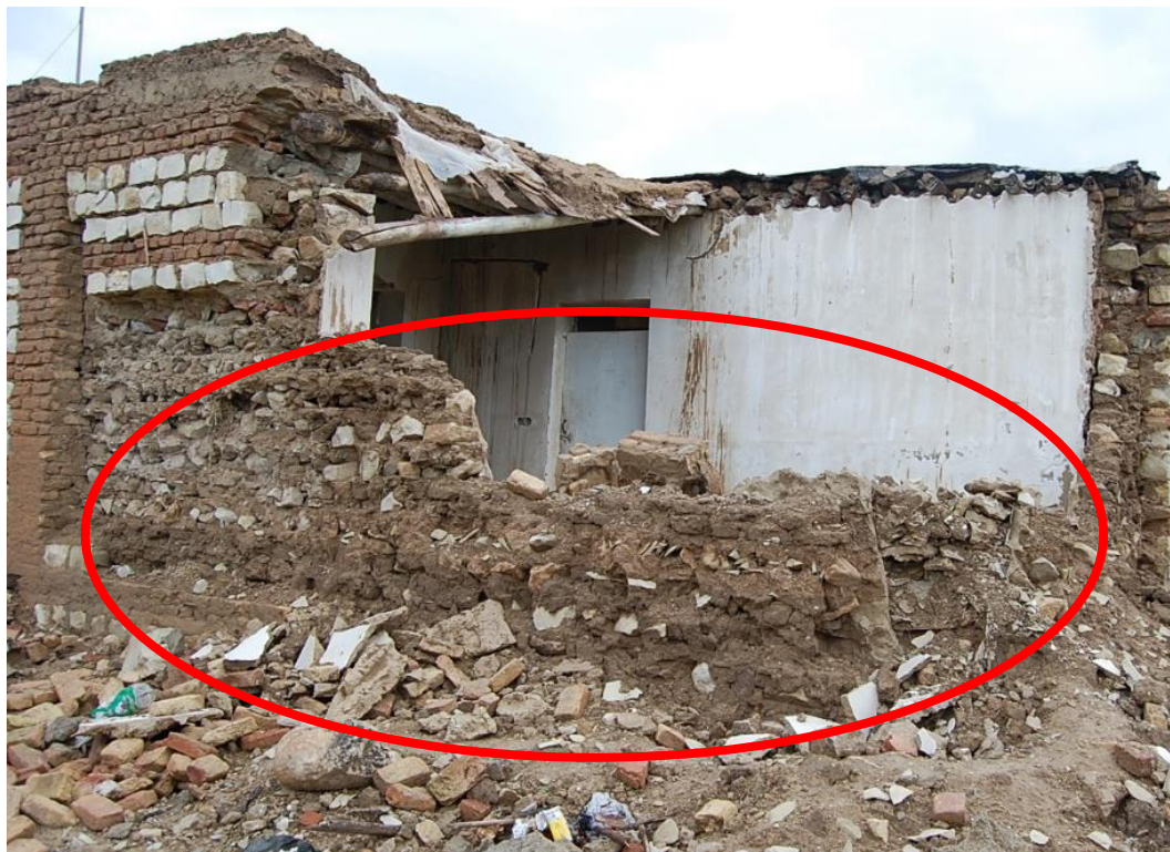
شکل (۶-۱۷): وجود دیوار باربر ساخته شده از خشت و گل که در زلزله آسیب دیده است
