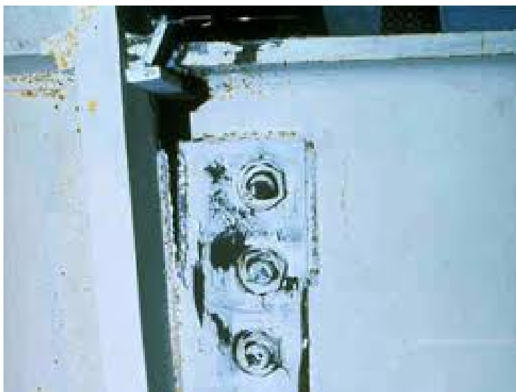
شکل (۴-۳۰): شکست پیچ
