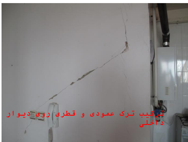
ترکیب ترک عمودی و قطری روی دیوار داخلی
