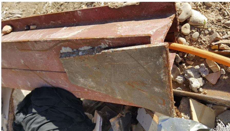
شکل (۴-۲۵): آسیب در جوش ورق بالاسری به ستون
