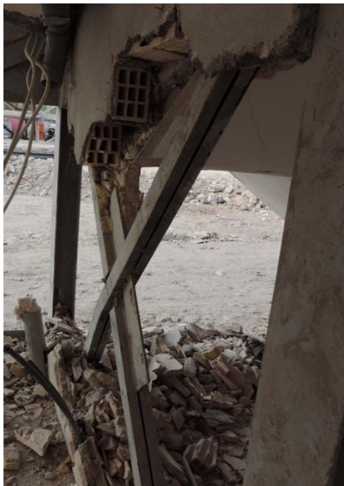
شکل (۴-۱۹): کمانش و طولیل شدگی مختصر مهاربند
