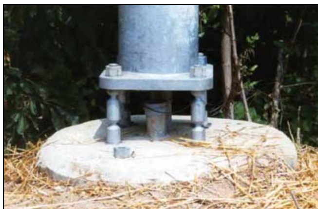
تصویر ۱-۲: نمونه ای از اتصالات شکست پذیر
