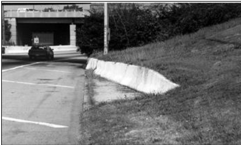
تصویر ۱۲-۵: نمونه‌ای از مهار ابتدای حفاظ بتنی در شیروانی
