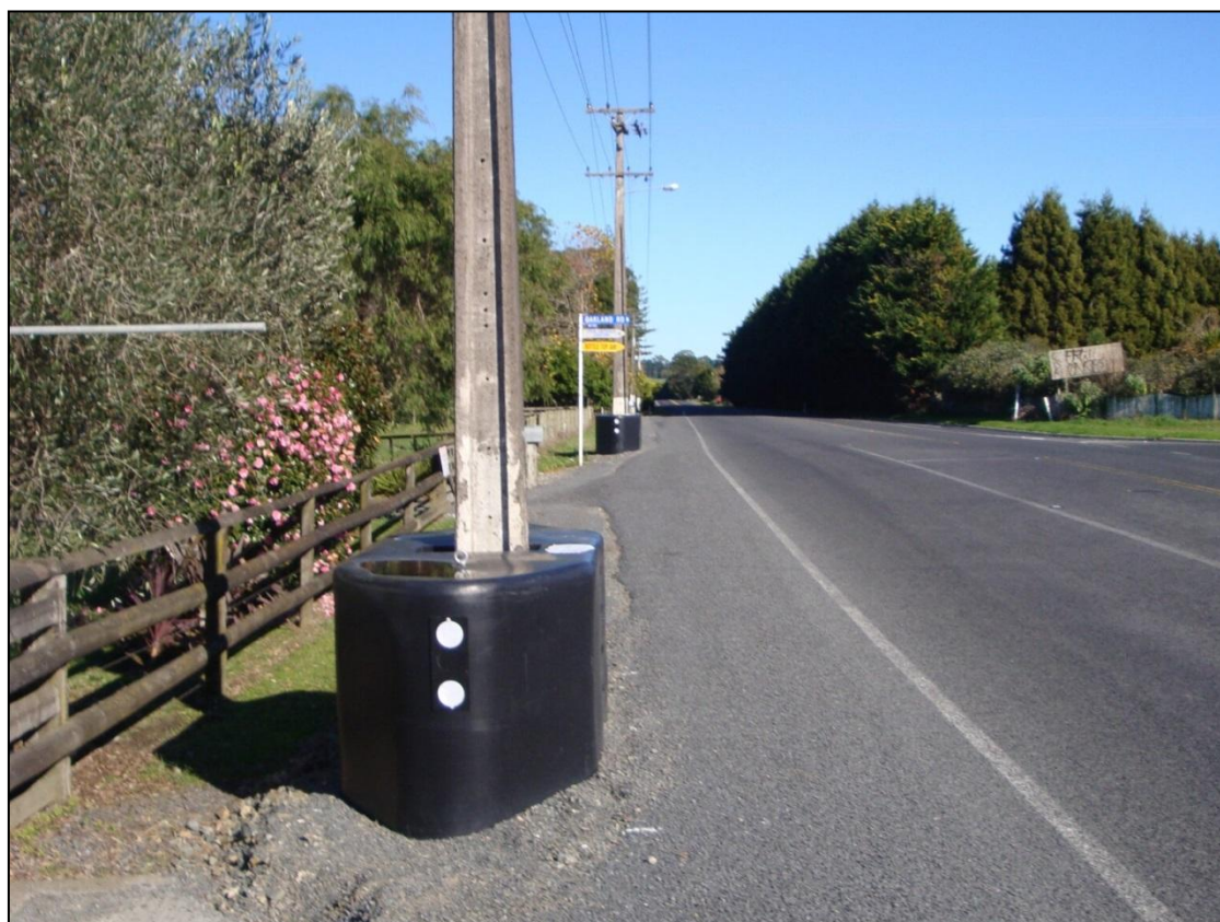
تصویر ۲-۳: استفاده از محافظ تک نقطه‌ای به منظور ایمن سازی موانع (مشخصات فنی این نوع ضربه گیر در بند ۱۳-۱۴ ارایه شده است)
