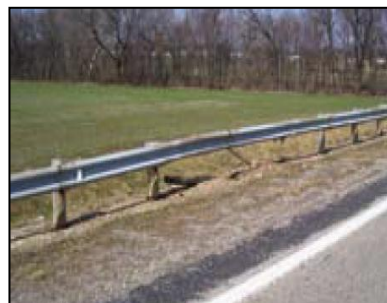
الف: یک یا ۲ پایه خراب‌شده و سپر سالم است
