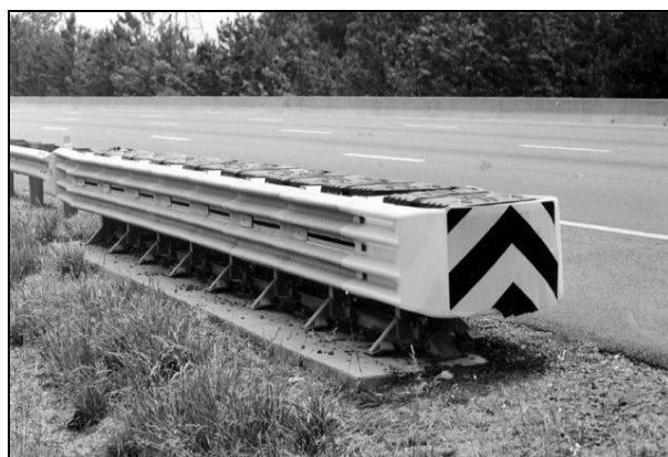
تصویر ۱۳-۱۹: ضربه گیر کواد گارد استاندارد
