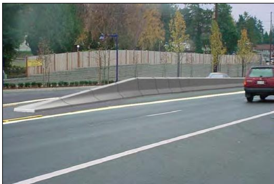
تصویر ۱۲-۳: شیب‌دار کردن انتهای حفاظ بتنی
