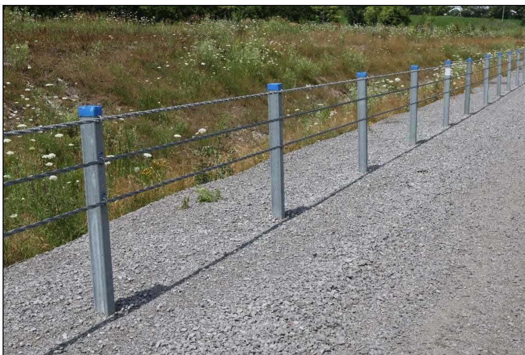
تصویر ۷-۱: نمایی از حفاظ سه کابلی
