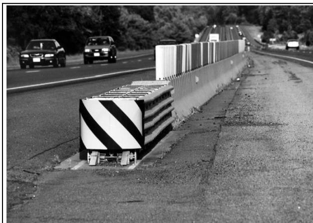
تصویر ۱۳-۱۸: ضربه گیر کاهش دهنده ترینیتی
