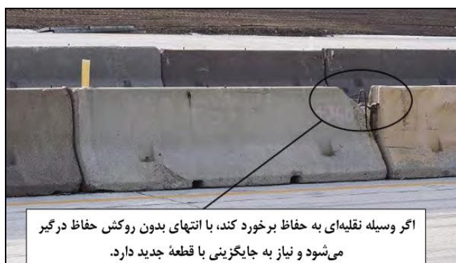
تصویر پ ۳: نمونه‌هایی از آسیب دیدگی حفاظ بتنی که باید قطعه تعویض شود
