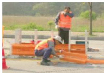
نصب دیواره‌ی ضربه گیر
