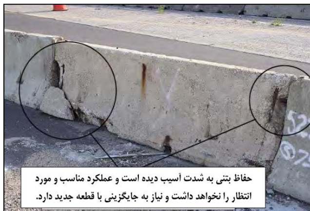
تصویر پ ۲: نمونه‌هایی از آسیب دیدگی حفاظ بتنی که باید قطعه تعویض شود
