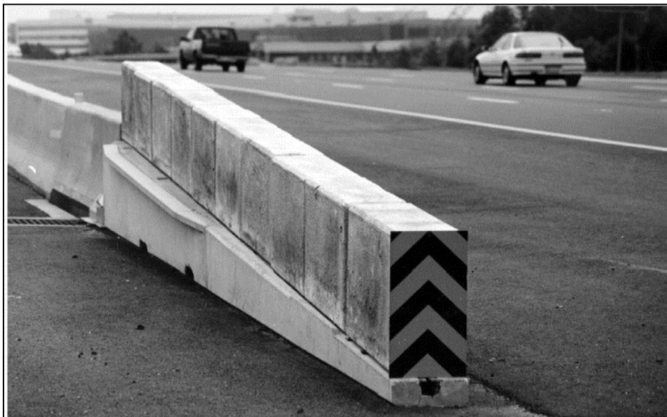
تصویر ۱۲-۱۷: ضربه گیر مکمل انتهای حفاظ بتنی
