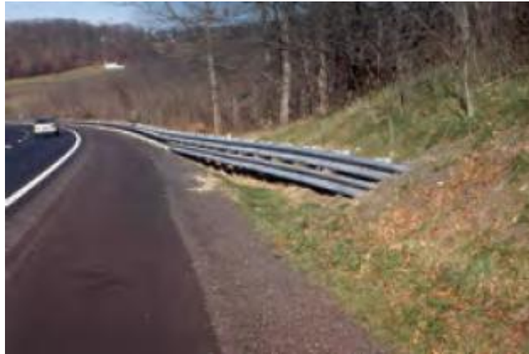
تصویر ۴-۱۲: نمونه‌ای از مهار ابتدای حفاظ فلزی در شیروانی
