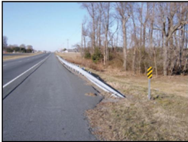
تصویر ۱۲-۱: نمونه‌ای از بالی شکل کردن و فروبردن ابتدای حفاظ در زمین
