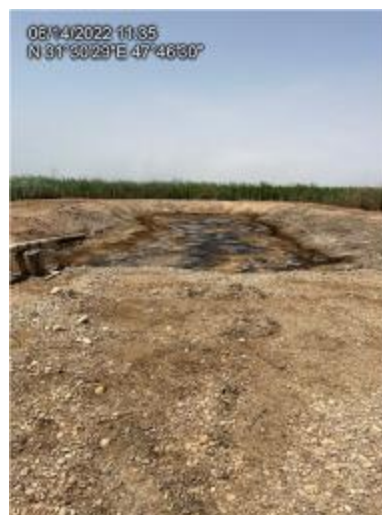
شکل ۲-۳۸: عدم آب بندی کف و دیواره های گودال آتشی (نفوذ در زمان سیلاب یا آب دائم)
