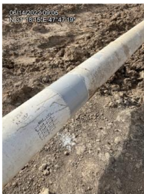
شکل ۲-۱۷: خطوط لوله مدفون در حال احداث به قطر ۱۴ اینچ اینچ به صورت مدفون
