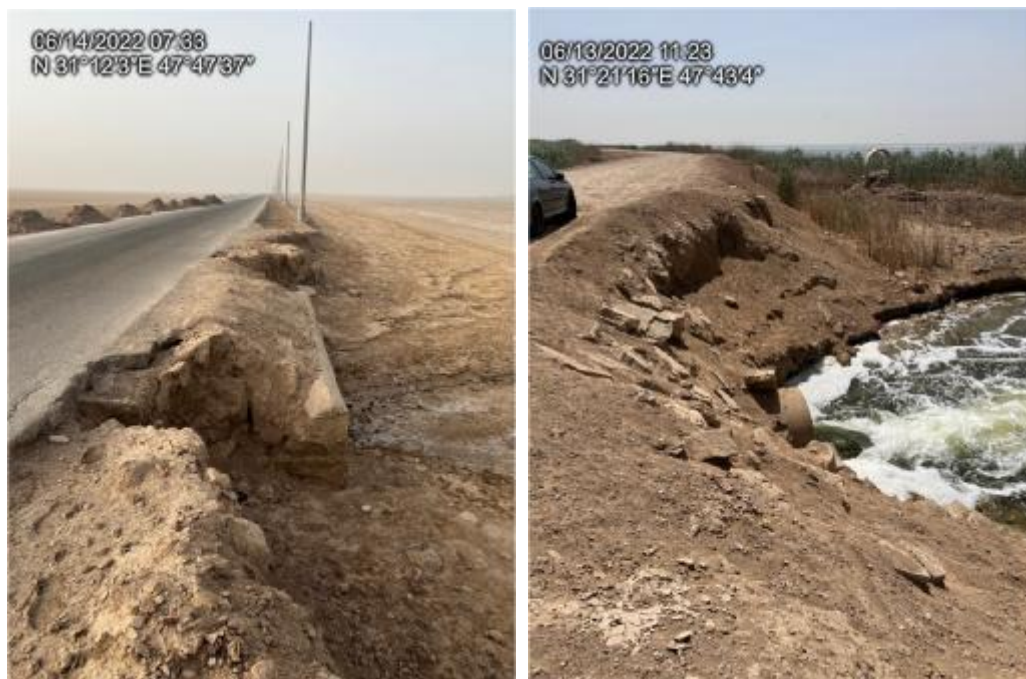
شکل ۲-۱۵: آبشستگی جداره جاده در کناره کالورت ها
