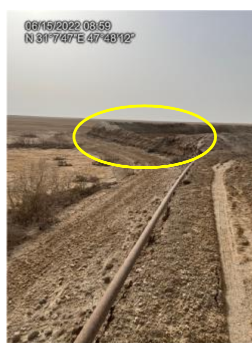
شکل ۲-۳۶: آبشستگی جداره گودال آتش، محل آبشستگی با بیضی زرد مشخص گردیده است.
