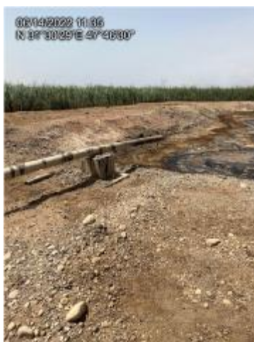
شکل ۲-۲۲: خط لوله فولادی به قطر ۴ اینچ برای انتقال مواد زائد به گودال آتش
