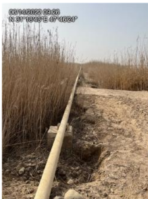
شکل ۲-۳۵: آبشستگی جاده دسترسی به گودال آتش
