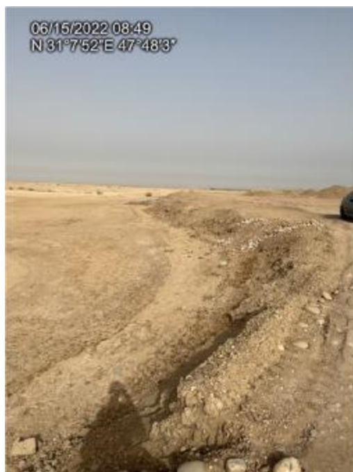
شکل ۲-۳۴: آبستگی جداره خاکریز سلرها
