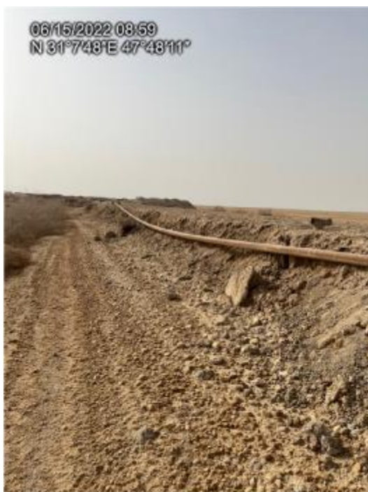
شکل ۲-۲۵: ناپایداری برخی از خطوط لوله گودال آتش ناشی از آبستگي كناره جاده فرعی
