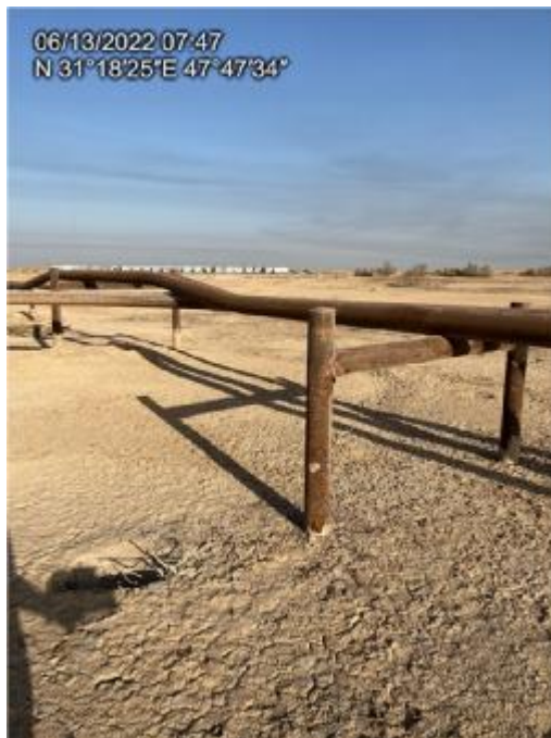
شکل ۲-۳۷: تماس نقطه ای خطوط لوله با تکیه گاه، تمرکز تنش در محل اتکا و آسیب دیدگی خط لوله و پوشش آن (در صورت وجود) در محل اتکای خط لوله به تکیه گاه
