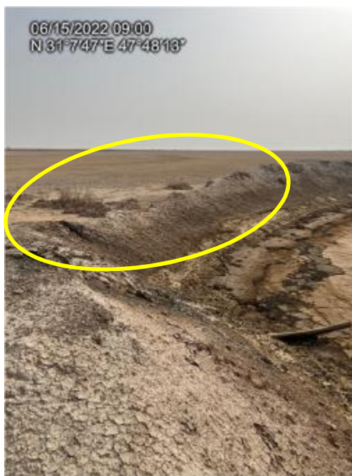
شکل ۲-۳۶: آبشستگی جداره گودال آتش، محل آبشستگی با بیضی زرد مشخص گردیده است.
