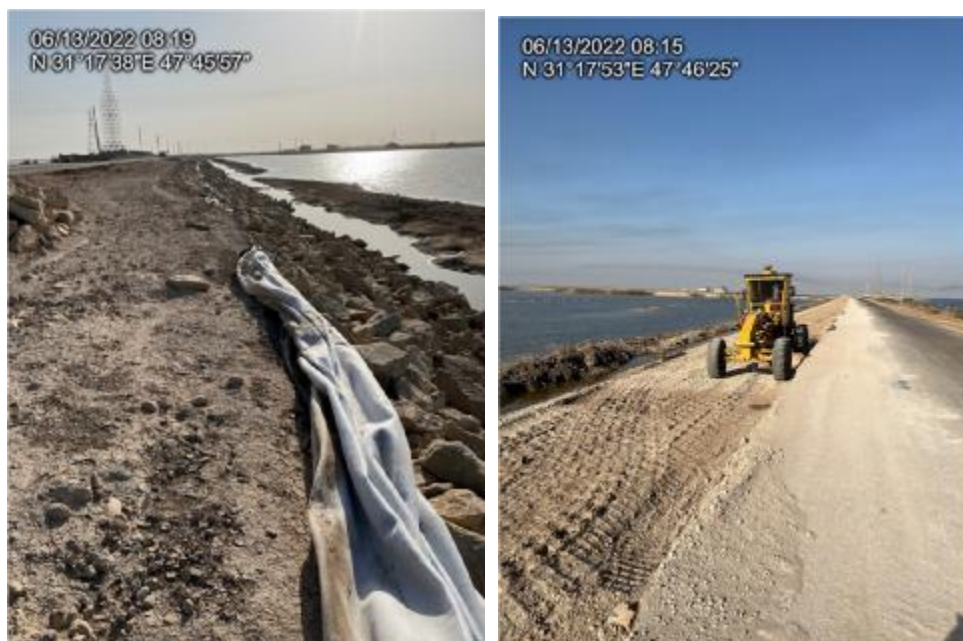
شکل ۲-۴: ترمیم کناره - به صورت ژئوتکستایل و ریپ رپ
