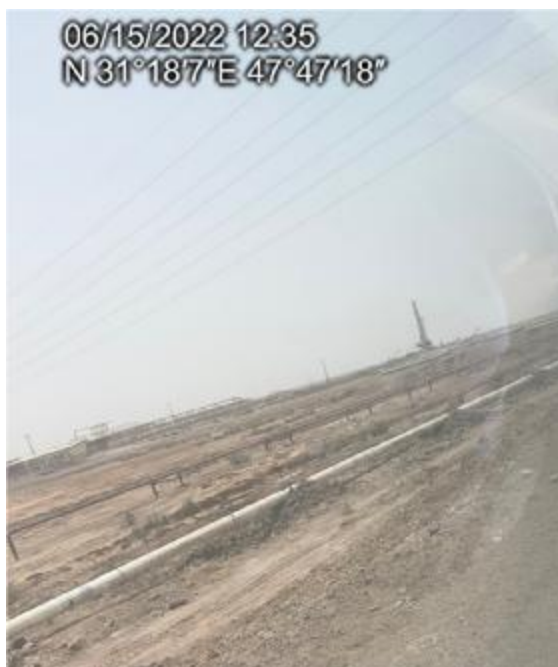
شکل ۲-۱۷: خطوط لوله مدفون در حال احداث به قطر ۱۴ اینچ اینچ به صورت مدفون
