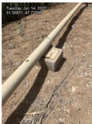
شکل ۲-۲۲: خط لوله فولادی به قطر ۴ اینچ برای انتقال مواد زائد به گودال آتش
