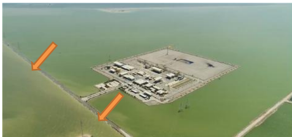
شکل ۲-۵: وارد شدن آب بر روی جاده و عامل وارد آمدن آسیب به لایه های زیرسازی و روسازی و تخریب خاکریز کناره جاده ها فلش ها نشان دهنده ی محل آسیب است
