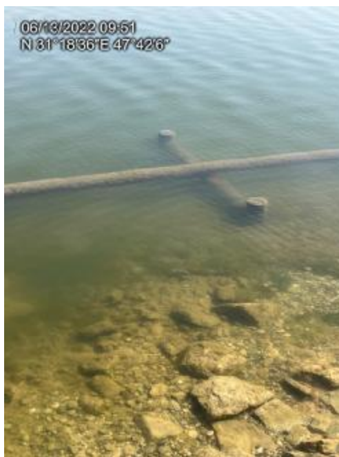
شکل ۲-۲۶: مستغرق شدن خطوط لوله
