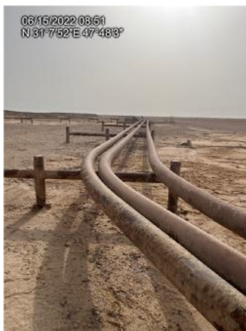
شکل ۲-۱۸: خطوط لوله فولادی با قطر ۸ اینچ عبوری از روی تکیه گاه
