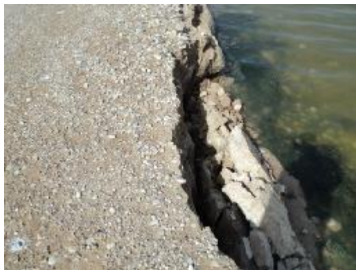
شکل ۲-۲: آبستگی کناره جاده ها
