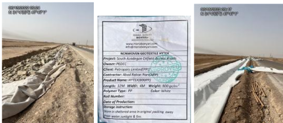
شکل ۲-۴: ترمیم کناره جاده با ژئوتکستایل و ریپ رپ
