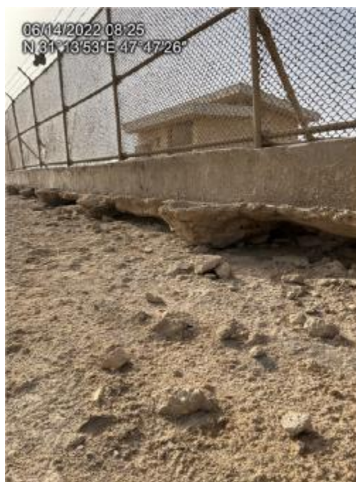
شکل ۲-۳۴: آبستگی جداره خاکریز سلرها
