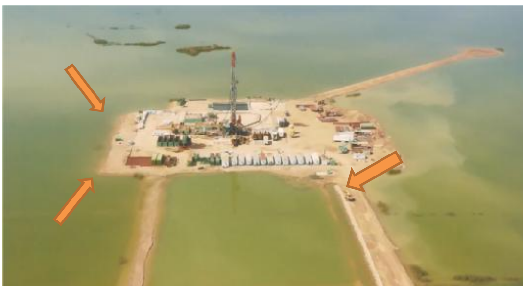
شکل ۲-۳۲: تراوش آب سیلاب از طریف کف یا بدنه (فلش ها نشان دهندهی محل خرابی است)
