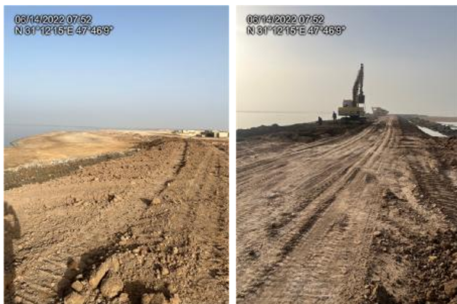
شکل ۲-۴۳: ترمیم کناره سلرها با شیب ۱:۳ و استفاده از ژئوتکستایل همراه با ریپ رپ
