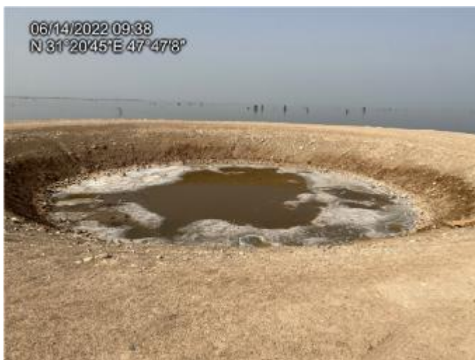
شکل ۲-۳۸: عدم آب بندی کف و دیواره های گودال آتشی (نفوذ در زمان سیلاب یا آب دائم)
