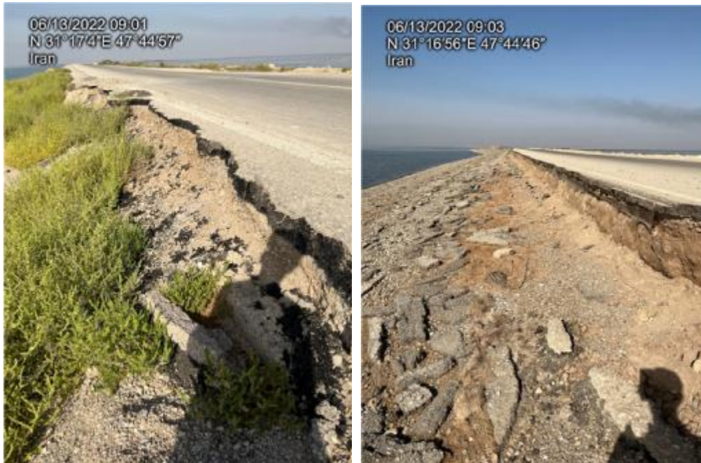
شکل ۲-۷: آبستگي کناره جاده ها
