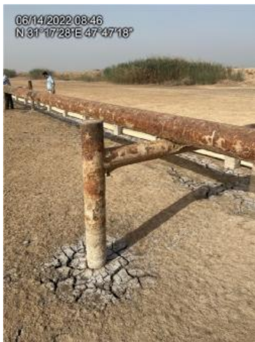
شکل ۲-۱۸: خطوط لوله فولادی با قطر ۸ اینچ عبوری از روی تکیه گاه
