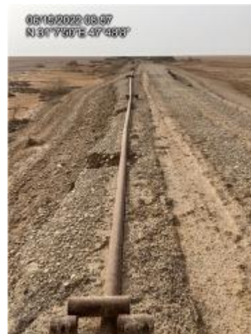
شکل ۲-۲۲: خط لوله فولادی به قطر ۴ اینچ برای انتقال مواد زائد به گودال آتش
