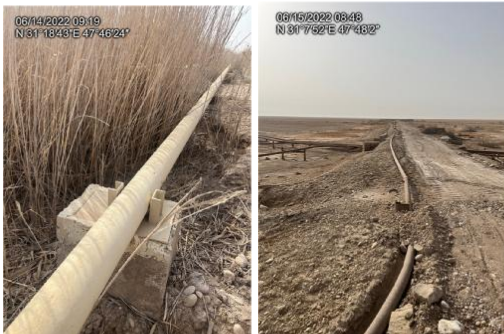
شکل ۲-۴۲: عدم استفاده از نشیمن گاه مناسب برای لوله به سمت گودال آتش
