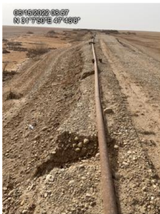
شکل ۲-۲۵: ناپایداری برخی از خطوط لوله گودال آتش ناشی از آبستگي كناره جاده فرعی
