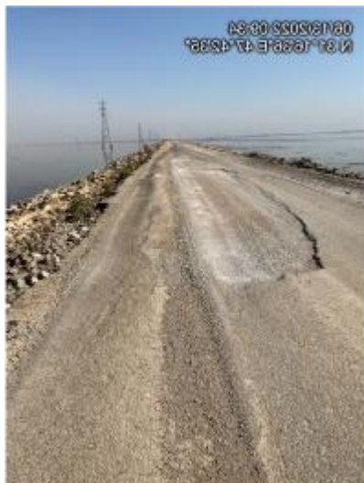
شکل ۲-۱۲: نشست نامنظم جاده
