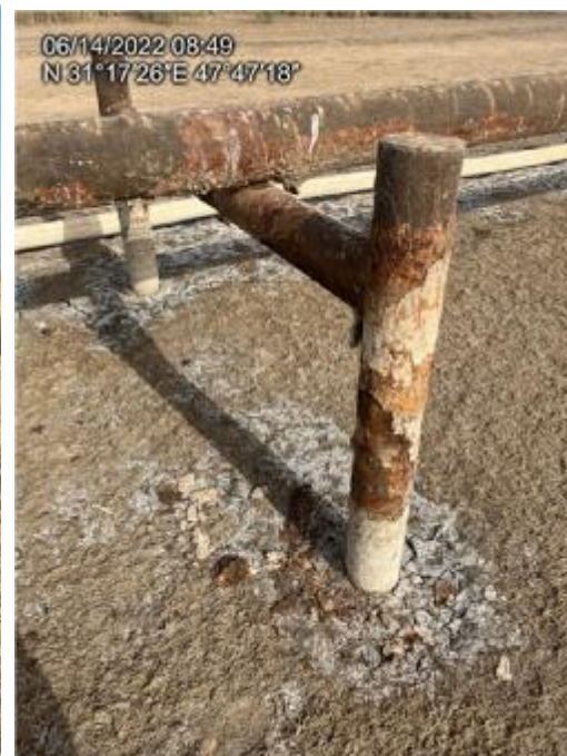
شکل ۲-۳۷: تماس نقطه ای خطوط لوله با تکیه گاه، تمرکز تنش در محل اتکا و آسیب دیدگی خط لوله و پوشش آن (در صورت وجود) در محل اتکای خط لوله به تکیه گاه
