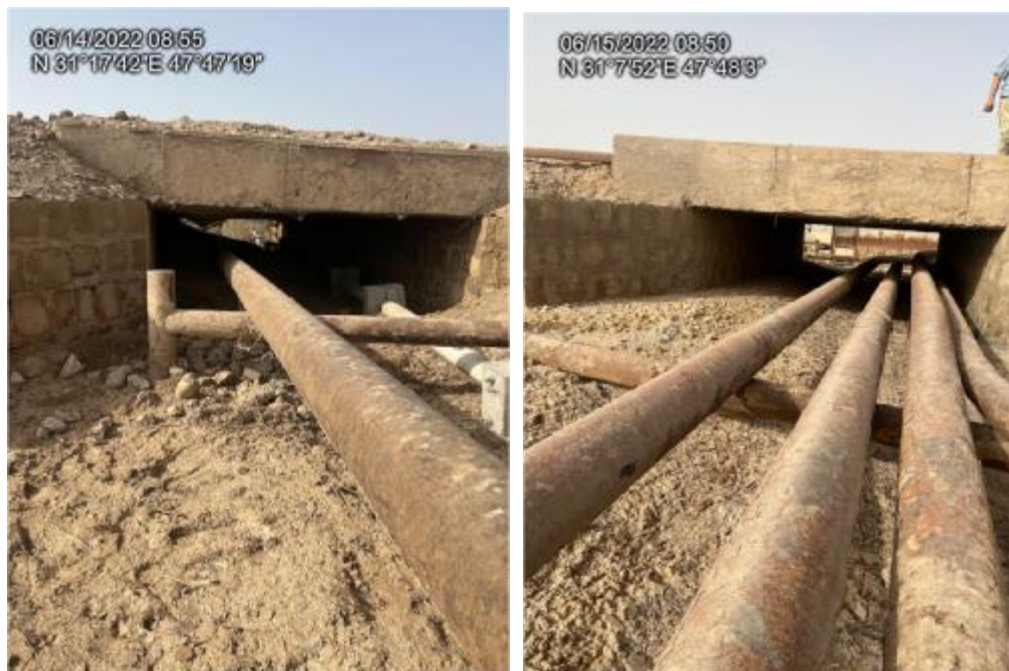
شکل ۲-۴۱: عبور خطوط لوله عمود بر جاده از داخل کالورت جاده ها
