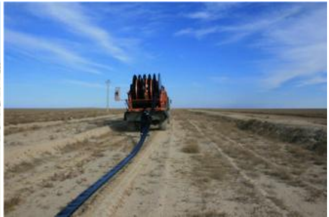
شکل ۳-۲: لوله های انعطاف پذیر collapsible
