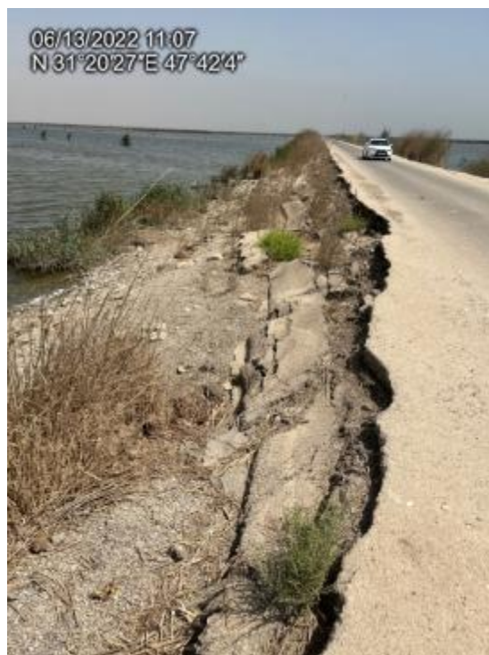
شکل ۲-۸: آبشستگی کناره جاده ها
