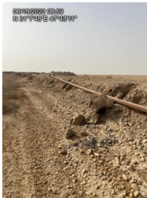
شکل ۲-۳۵: آبشستگی جاده دسترسی به گودال آتش
