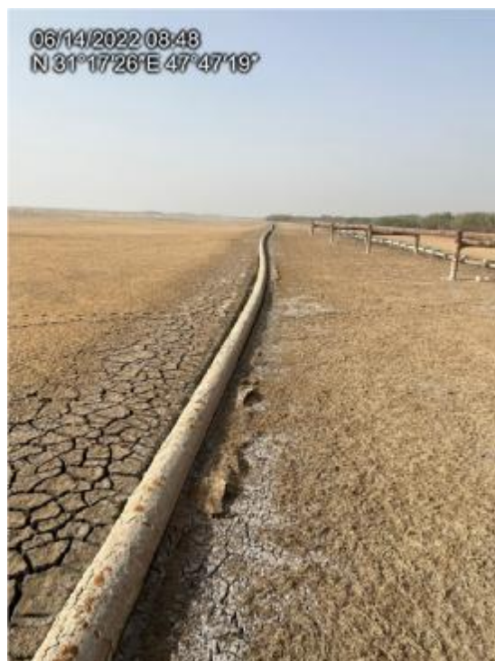
شکل ۲-۲۱: خطوط لوله عبوری از کف تالاب به قطر ۸ اینچ بدون تکیه گاه
