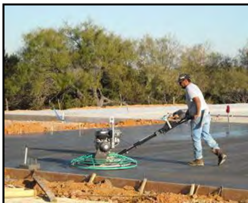
شکل ۵-۶- پرداخت سطحی کف با ماله‌ی پروانه‌ای
