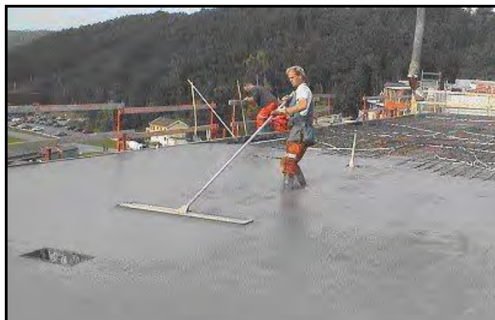
شکل پ. ۲-۶- پرداخت سطح بتن خودتراکم
