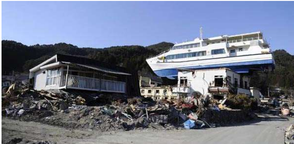
شکل ت-۱۵-۱۱ امکان انتقال اشیای غیرمتعارف در زمانی که ارتفاع موج یا عمق آب‌گرفتگی سونامی بسیار زیاد باشد وجود دارد
