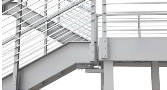
شکل ت-۸-۲۳ اتصال راه‌پله فولادی
