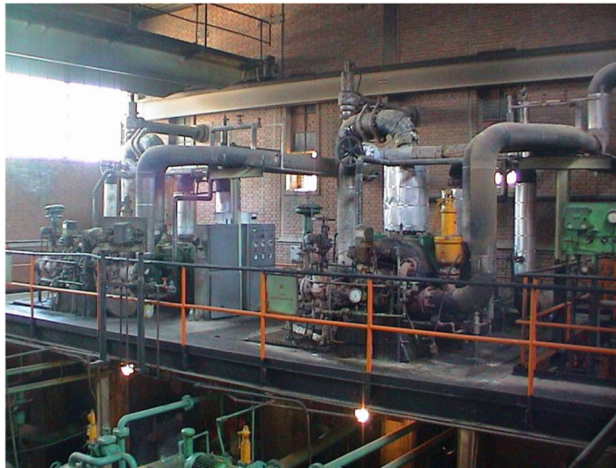
شکل ت-۸-۱ نمونه‌ای از اجزای غیرسازه‌ای در تأسیسات صنعت نفت- کمپرسور هوا
