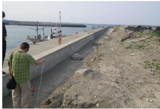
شکل ت-۱۳-۱۵ نمونه‌ای از آب‌شستگی ناشی از سرریز سیال از روی دیوار مانع سونامی و آب‌شستگی هدایت شده
