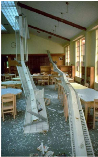
شکل ت-۸-۳۲ آسیب در تجهیزات برقی در زلزله بوژ هندوستان در سال ۲۰۰۱
