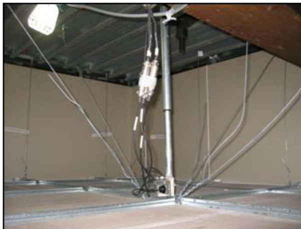
شکل ت-۸-۲۰-ب نمونه‌ای از مهار سقف کاذب با مهارهای کششی جانبی (مفتولی) به صورت مورب (تصویر اضافه شده در متن راهنما نیست)
