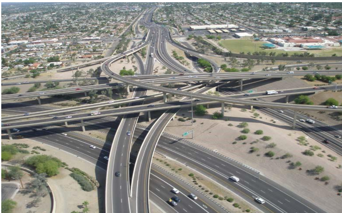
شکل ۶-۳۸- تبادل جهتی چهار سطحی
