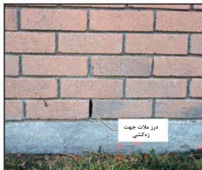
شکل ۵-۱۳- خالی گذاشتن درز ملات جهت زه‌کشی
