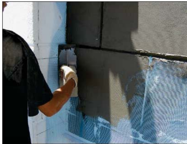
شکل ۱۱-۷- اجرای لایه‌های پوششی
