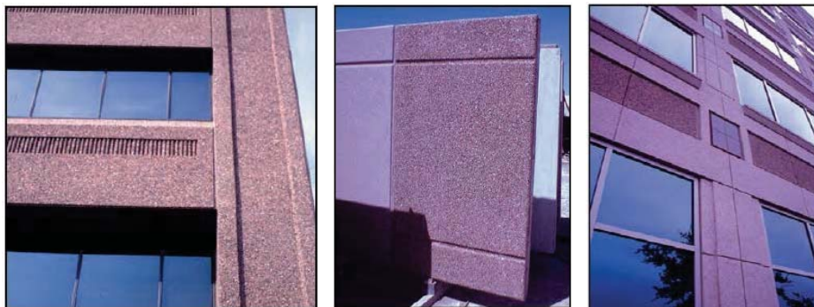
شکل ۱-۲۰- پانل بتنی پیش‌ساخته با جزئیات سطح صیقلی ب- پانل‌های بتنی پیش‌ساخته با سطح سمباده‌ای کم و متوسط ج- پانل
