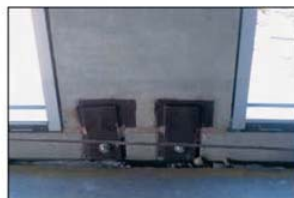
شکل ۱۰-۸- تیپ اتصالات دوخت به پشت که در سه جهت قابل تنظیم می‌باشند
