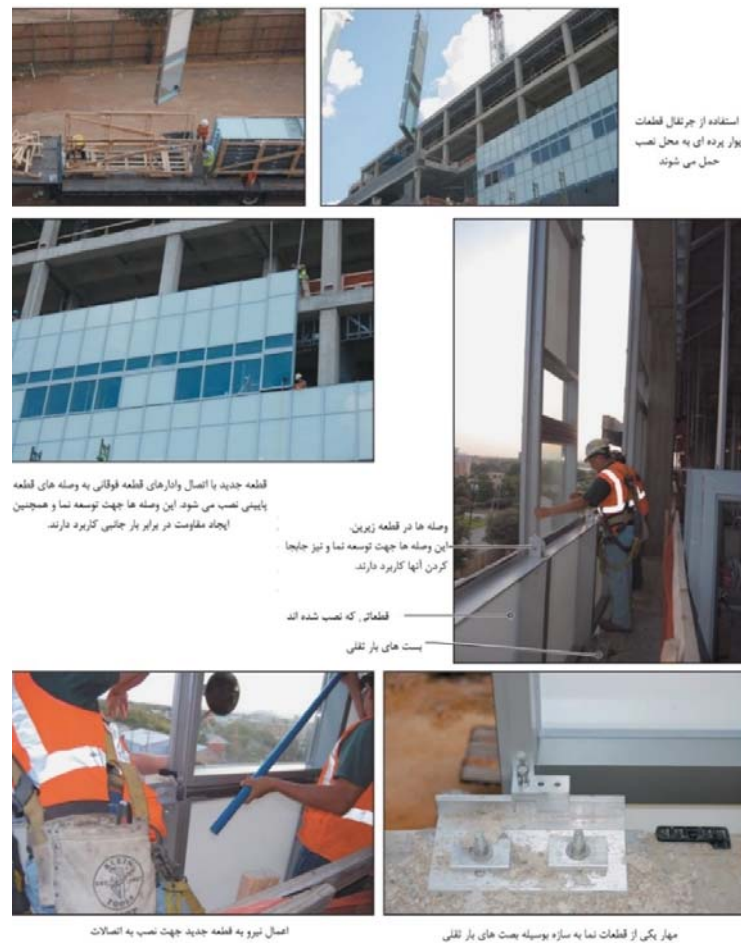
شکل ۹-۱۲- مراحل نصب نمای پرده‌ای یکپارچه
