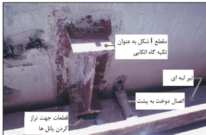
شکل ۱۰-۵- پروفیل قوطی شکل به عنوان تکیه گاه اتکایی و پیچ تنظیم ارتفاع
