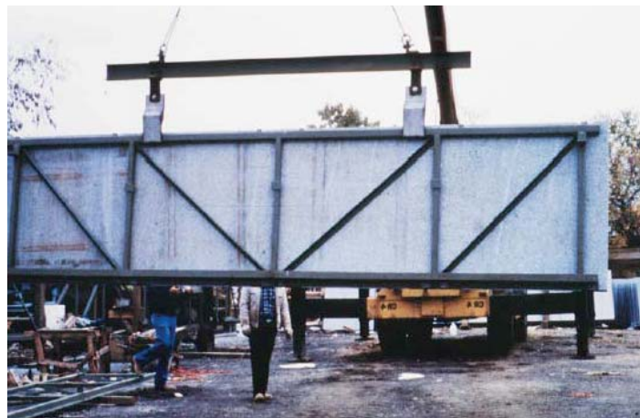
شکل ۴-۲۱- پانل دیواری پرده‌ای پیش ساخته سنگی
