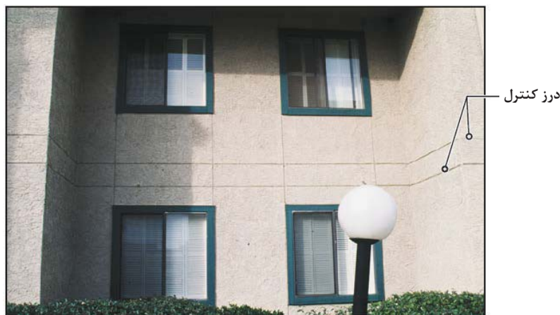
شکل ۶-۲- نمونه درزهای کنترل بر روی نمای سیمانی
