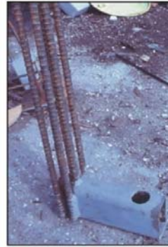
قوطی فولادی جهت تکیه گاه اتکایی (ب)
