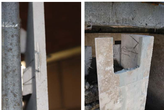
شکل ۲-۴- نمونه‌هایی از مه‌ارهای سیمی فولادی
