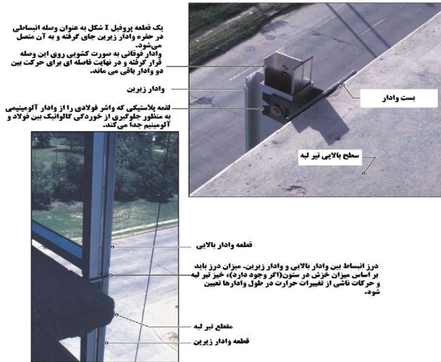
شکل ۹-۷- نمونه اتصال انبساطی بین دو قطعه وادار
