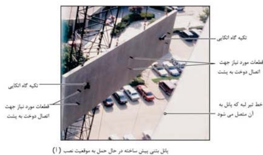
شکل ۱۰-۷- نمونه‌ای از اتصال دوخت به پشت
