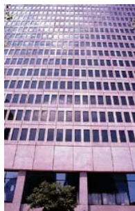
شکل ۱-۱۰- نمای ساختمان ساخته شده با پانل‌های بتنی پیش‌ساخته
