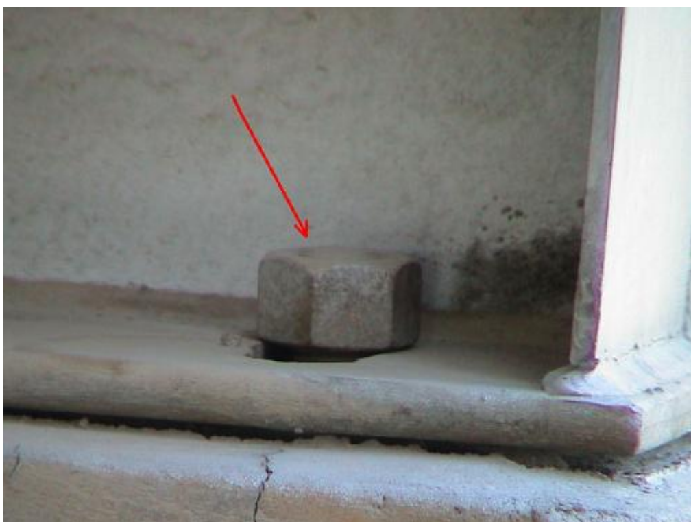
شکل ۱۸- طول کم رزوه شده پیچ اتصال
