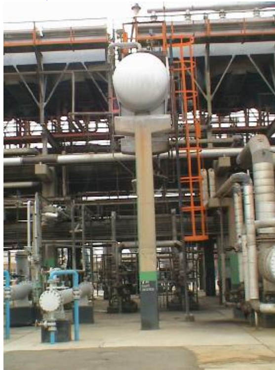
شکل ۱۱- عدم مهار تجهیزات مرتفع و احتمال واژگونی در اثر زلزله
