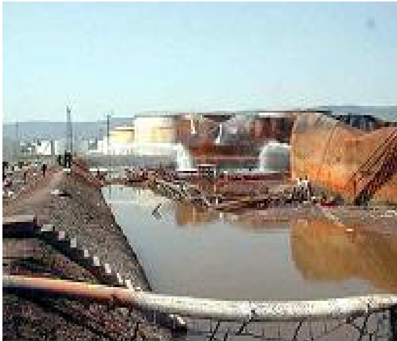
شکل ۵- تخریب مخازن در اثر آتش سوزی در زلزله ازمیت
