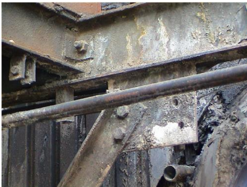
شکل ۲۲- حذف بادبندی جهت تعمیرات و عدم نصب مجدد ( نمای نزدیک )
