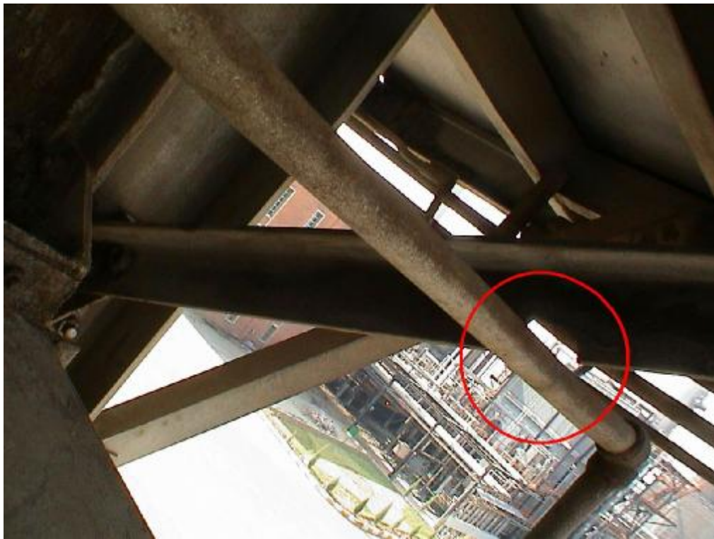
شکل ۲۳- ایجاد برش در بادبندی ها جهت عبور لوله
