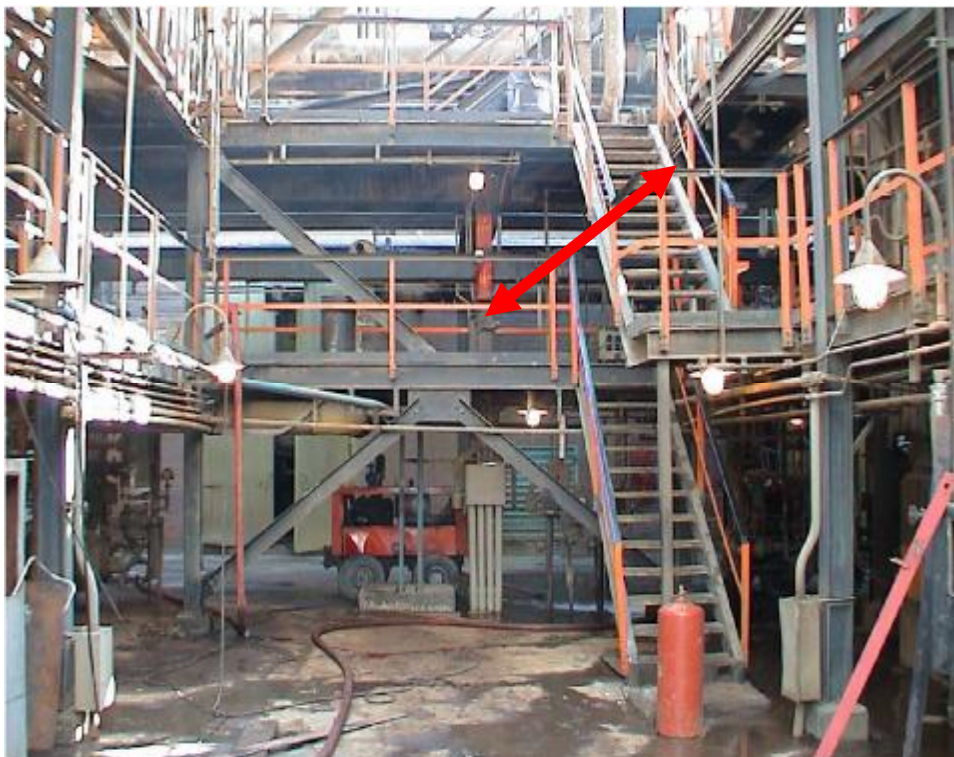
شکل ۲۱- حذف بادبندی جهت تعمیرات و عدم نصب مجدد ( نمای دور )
