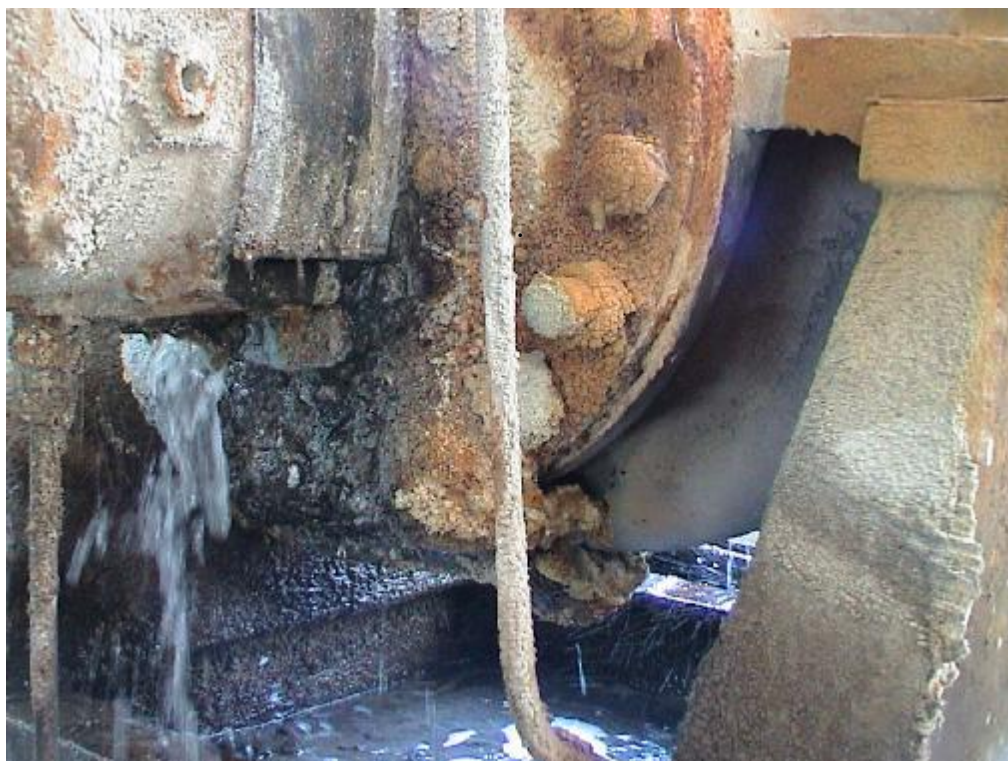
شکل ۲۶- کاهش ظرفیت سازه ای به علت خوردگی ناشی از نشت
