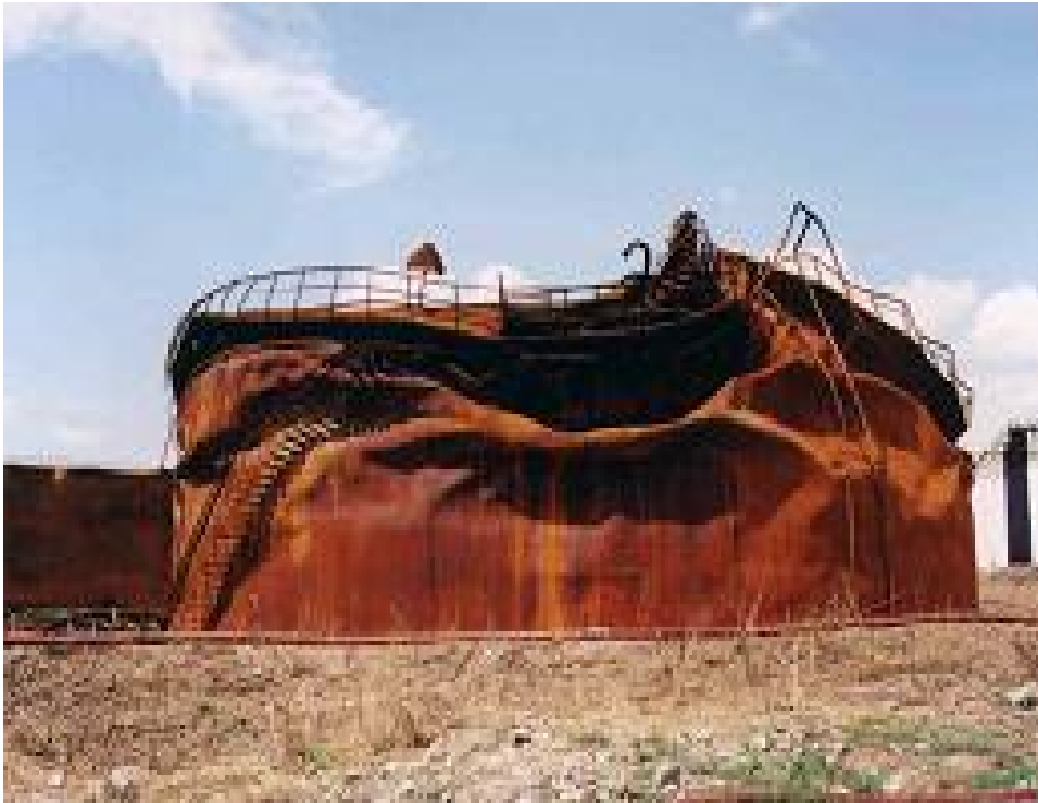
شکل ۳- نمایی از مخزن بعد از آتش سوزی در زلزله ازمیت
