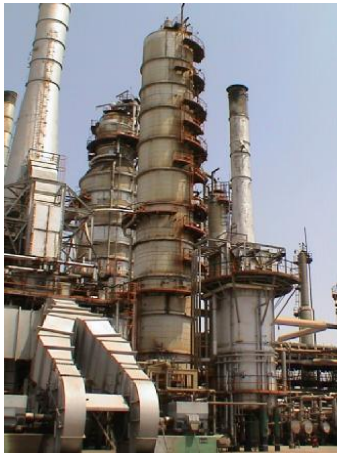
شکل ۱۲- عدم مهار تجهیزات مرتفع و احتمال واژگونی در اثر زلزله و ضربه به تجهیزات مجاور
