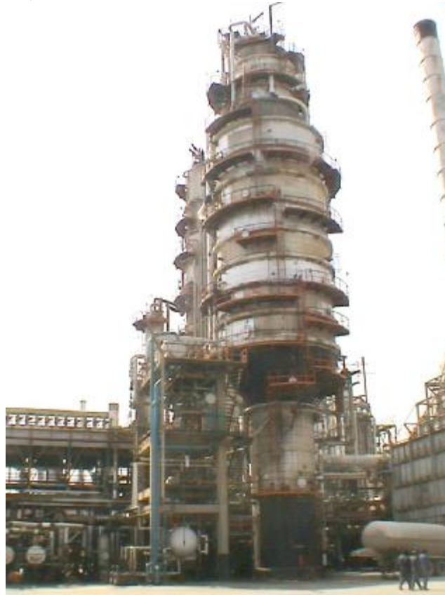
شکل ۱۳- احتمال واژگونی وسل تحت فشار در اثر زلزله
