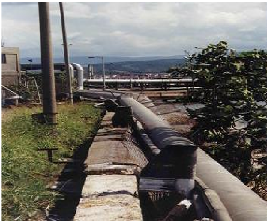
شکل ۷- نمونه ای از لغزش لوله از روی تکیه گاه به علت عدم مهار جانبی در زلزله آزمایش
