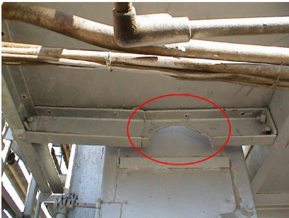
شکل ۲۵- کاهش ظرفیت سازه ای به علت تعمیرات
