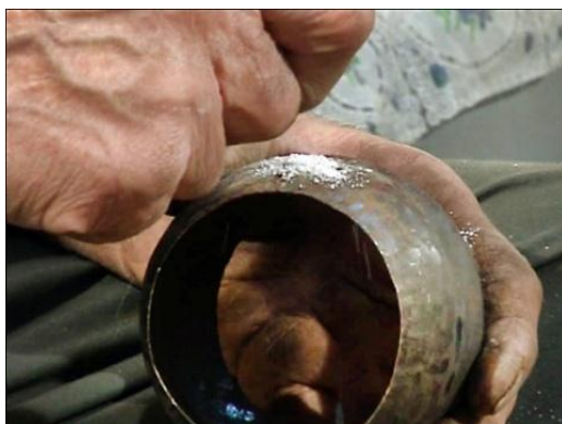
شکل ۹۶- استقرار تنکار و قطعات قلع روی درزهای بیرونی مخزن
