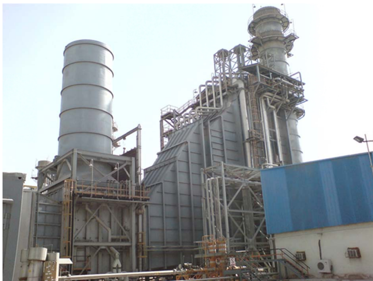
شکل ۴-۲۸- بویلر بازیافت (HRSG) در پروژه شماره ۱۰
