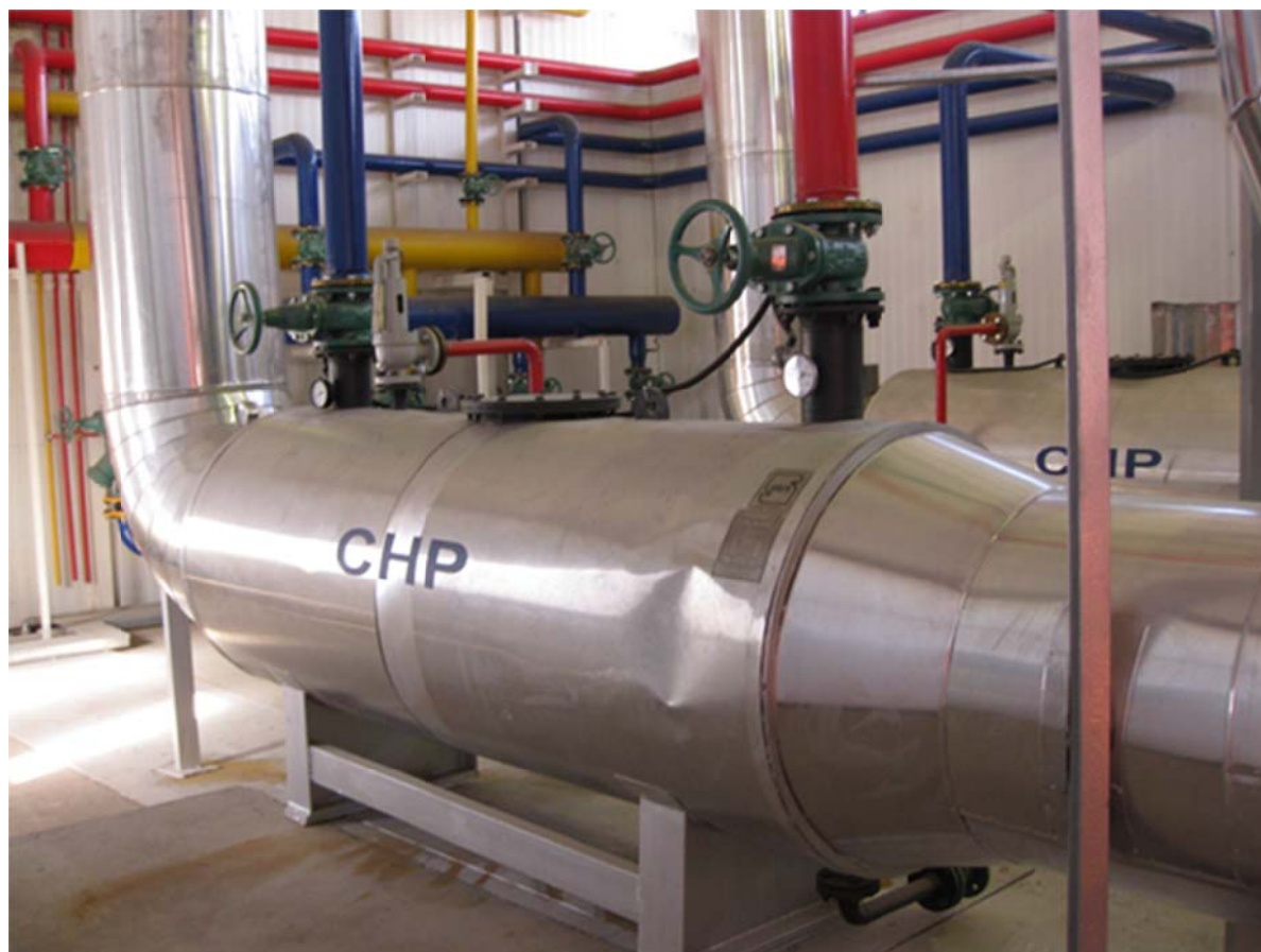
شکل ۴-۳- مبدل حرارتی در خروجی توربین در پروژه شماره ۱۱
