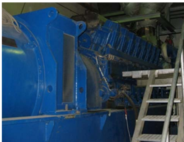
شکل ۴-۷- موتور پیستونی MWM مدل TCG 2032 [12]
