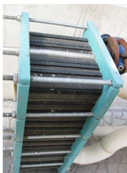
شکل ۴-۲۵- مبدل حرارتی جهت استفاده از حرارت آب خنک کننده بدنه موتور در CHP پروژه شماره ۹
