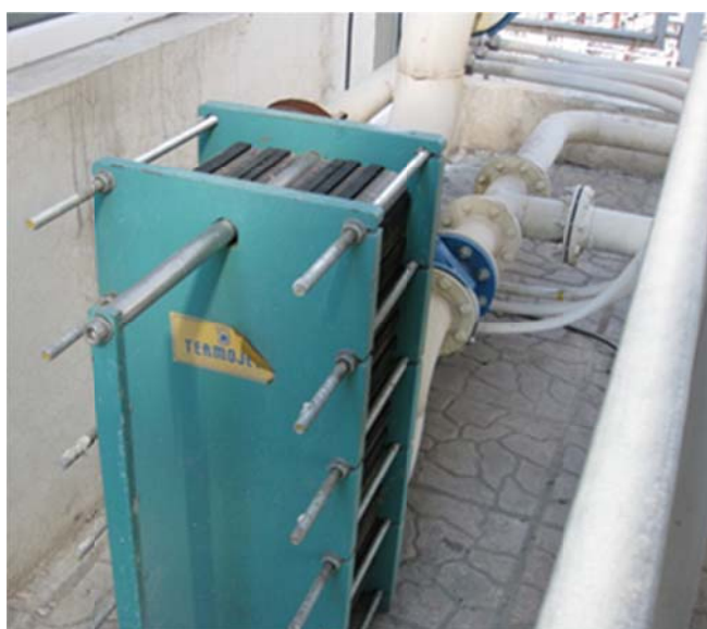
شکل ۴-۲۵- مبدل حرارتی جهت استفاده از حرارت آب خنک کننده بدنه موتور در CHP پروژه شماره ۹
