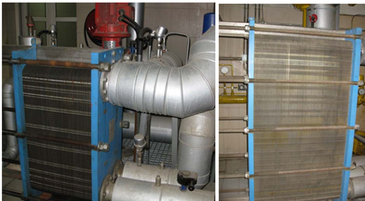
شکل ۴-۹- مبدل حرارتی جهت تولید آب گرم از بدنه موتور (سمت چپ) و روغن موتور (سمت راست)
