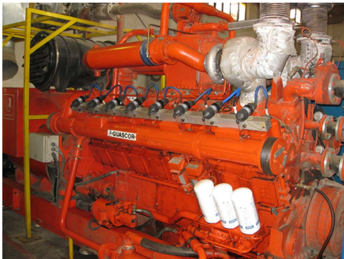
شکل ۴-۱۲- موتور GUASCOR مدل SFGLD 560 در پروژه شماره ۵
