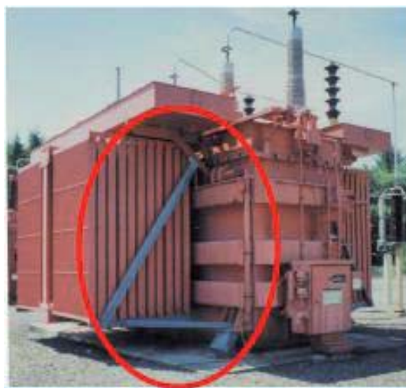
شکل ۵-۵ تقویت مهار بندی رادیاتور ترانس
