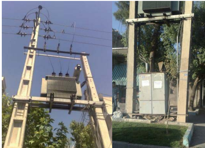
شکل ۵-۱۴ پایه‌های توزیع و ترانس هوایی
