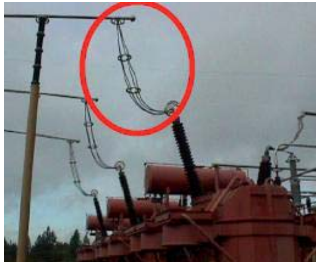
شکل ۵-۶ بهسازی اتصال بوش‌بینگ برای کنترل مد شکست اتصال و نشست روغن
