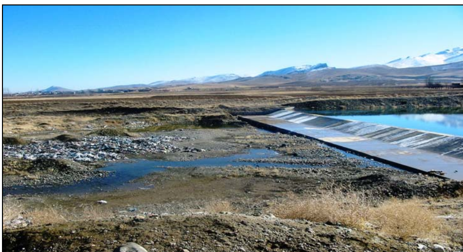
شکل‌های پ.۲-۱ و پ.۲-۲- حوضچه‌های تغذیه مصنوعی در بستر رودخانه ویهیج و زباله‌های شهر قروه در پایین دست یکی از حوضچه‌های تغذیه (نگاه به سوی شمال)
