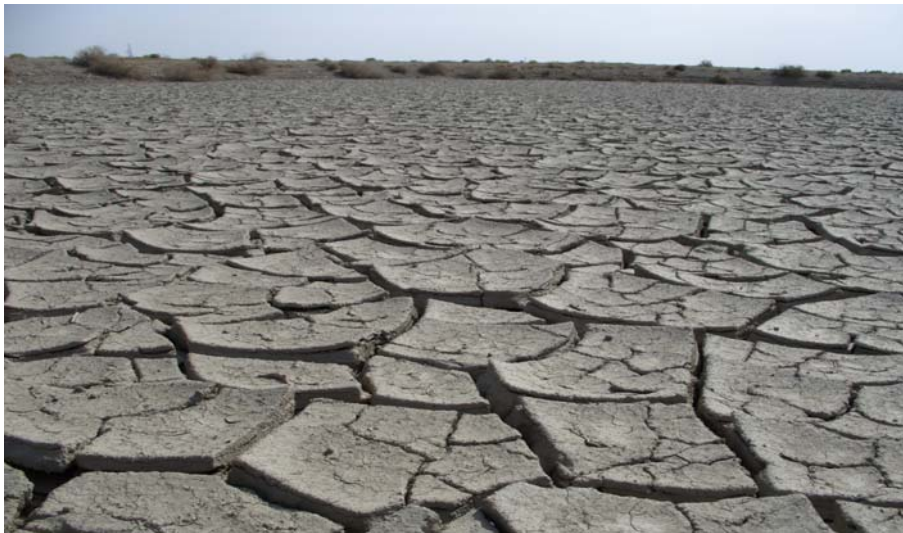
شکل پ.۱-۱- تجمع رسوبات رس و ماسه در کف یکی از حوضچه‌های تغذیه مصنوعی در منطقه شاهرود- شمال روستای ده ملا
