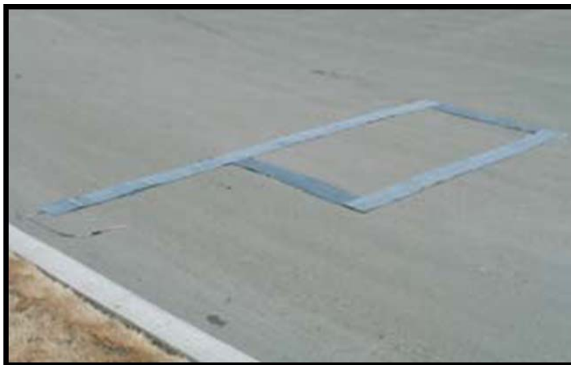
شکل ۲-۱۳- یک نمونه از حلقه القایی سیار نصب شده در سطح روسازی راه
