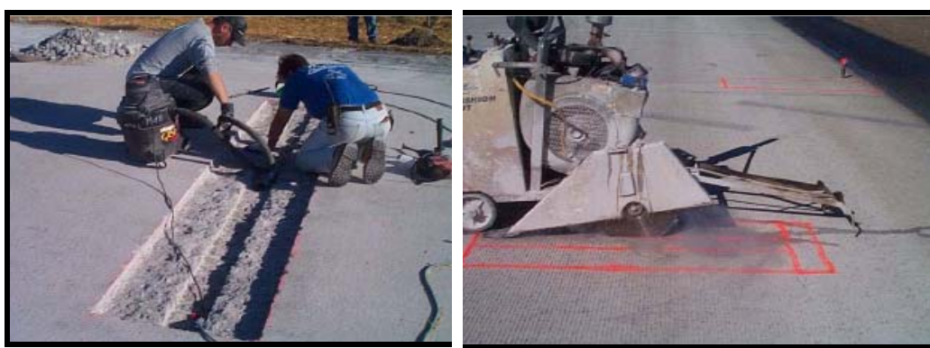
شکل ۴-۳۷- طریقه نصب صفحه خمشی
