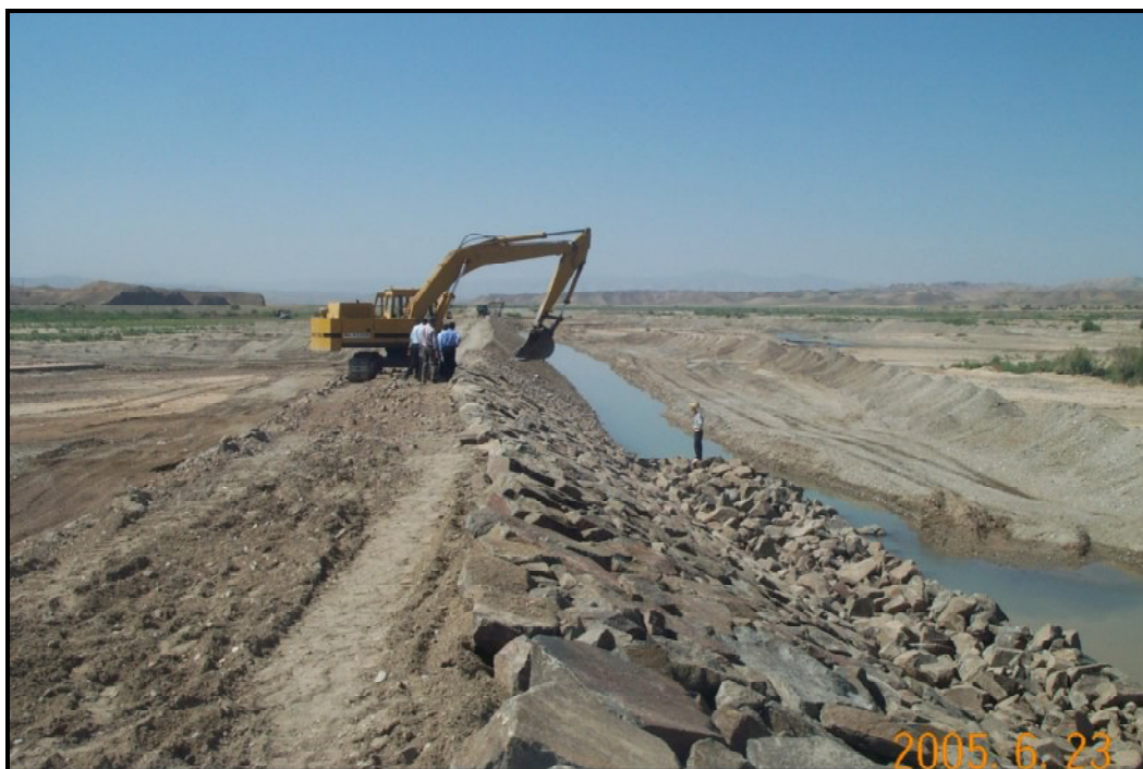
شکل ۶-۱۲- حفاظت با پوشش سنگی در رودخانه قزل‌اوزن
