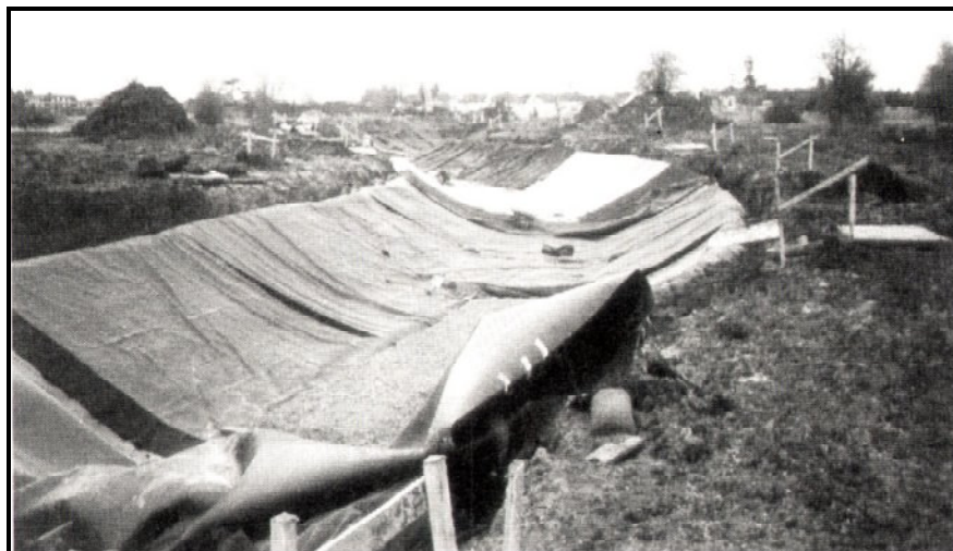
شکل ۷-۴- عملیات پوشش کف کانال انحراف دائمی در رودخانه اش
