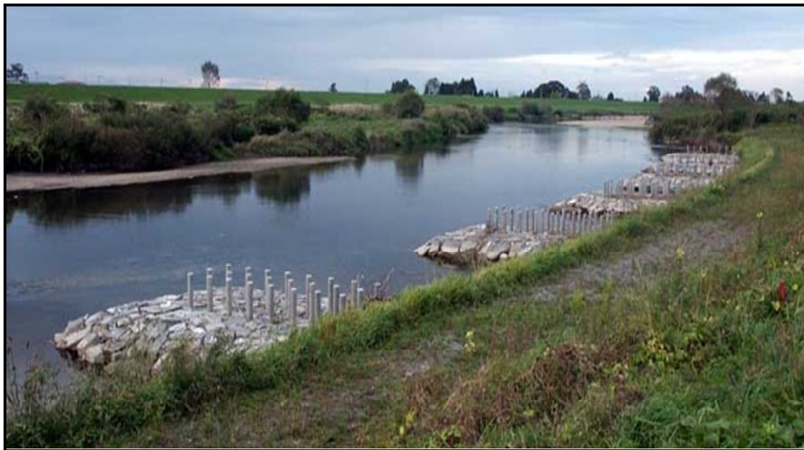
شکل ۶-۵ - احداث آبشکن به منظور بهبود شرایط زیست‌محیطی از تجارب در کشور ژاپن [۹]
