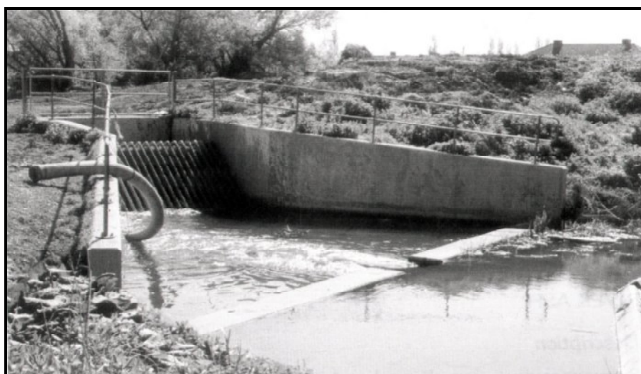
شکل ۷-۵- سازه ورودی جریان به کانال انحراف دائمی
