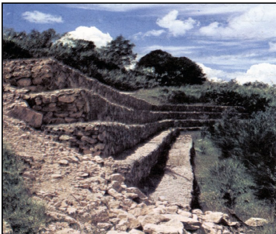
شکل ۶-۱۳- حفاظت با احداث دیوار توری سنگی [۸]
