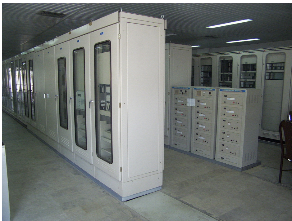
شکل (پ-۵-۹): قفسه‌های دستگاهها و تجهیزات ابزار دقیق
