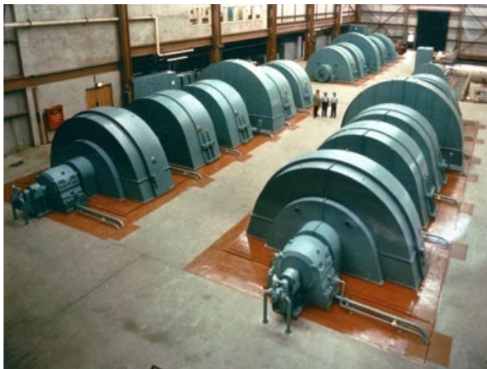
شکل (پ-۵-۲۱): موتور - ژنراتور
