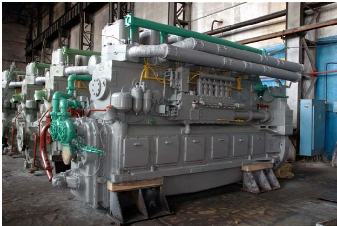
شکل (پ-۵-۲۲): موتور احتراقی - ژنراتورها
