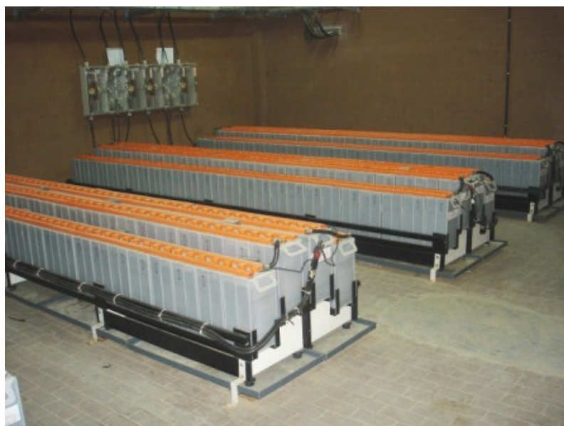
شکل (پ-۵-۱): باتری‌ها و قفسه‌های نگهدارنده آنها
