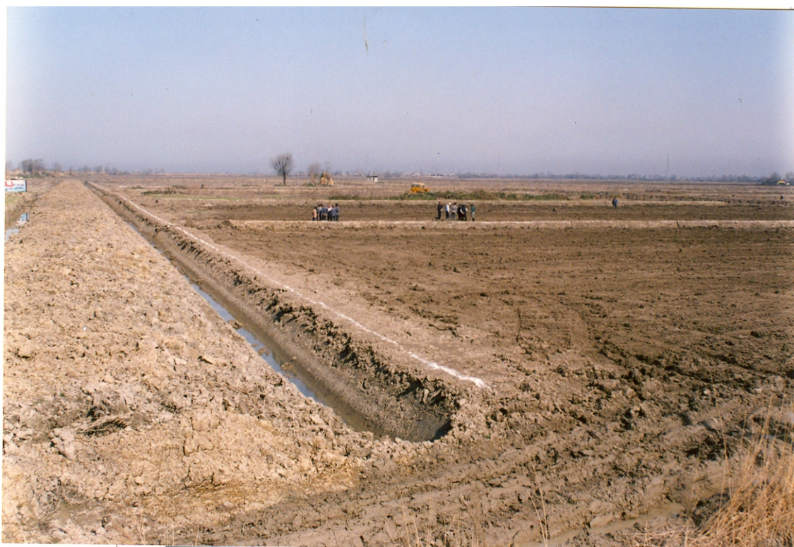
شکل شماره ۸- اراضی تسطیح شده و کانال های انتقال آب و جاده های بین مزارع
