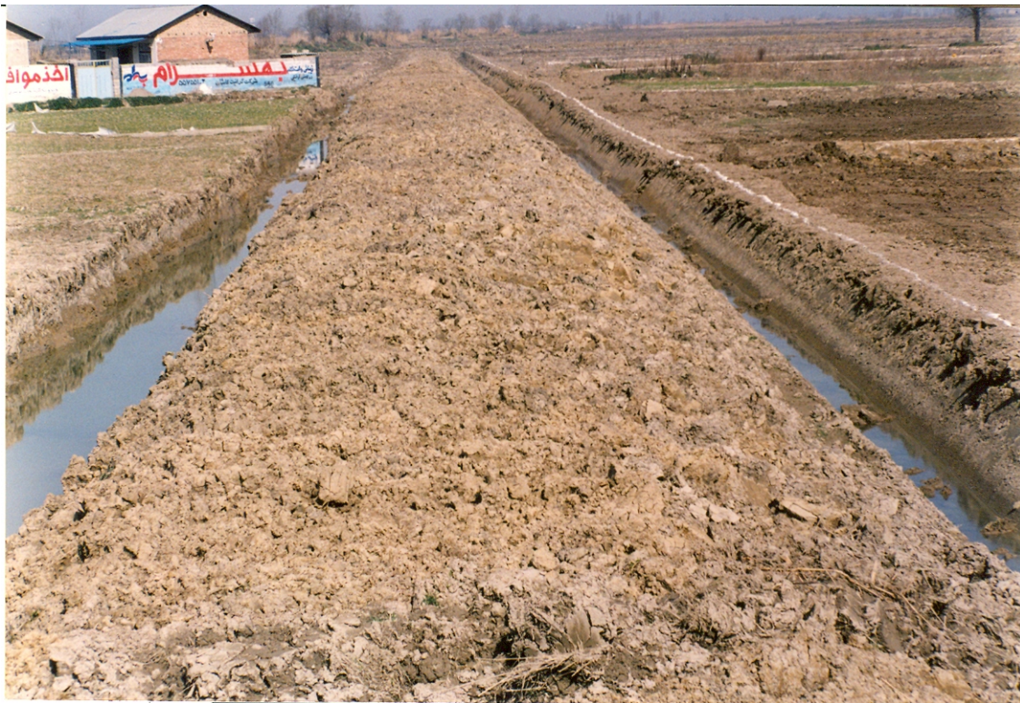
شکل شماره ۹- اراضی تسطیح شده و کانال های انتقال آب و جاده های بین مزارع
