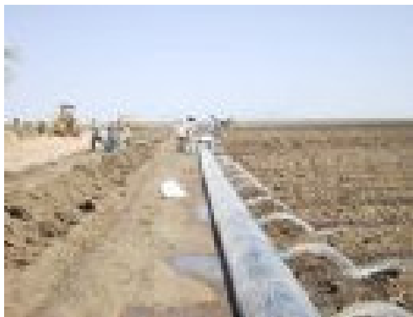
شکل ۲-۷- استفاده از لوله‌های دریچه‌دار (هیدروفلوم) به جای کانال درجه ۴
