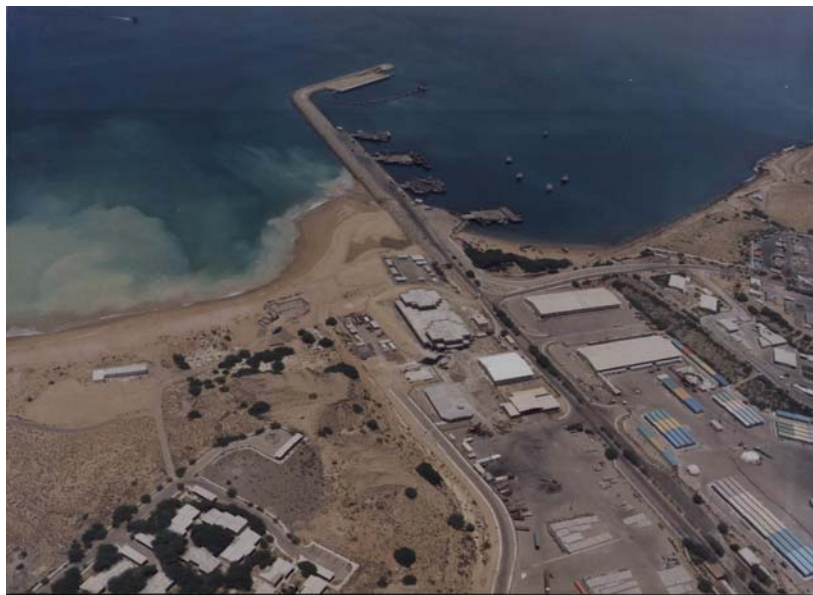
شکل ۶-۲ نمای اسکله شهید کالانتری در خلیج چابهار
