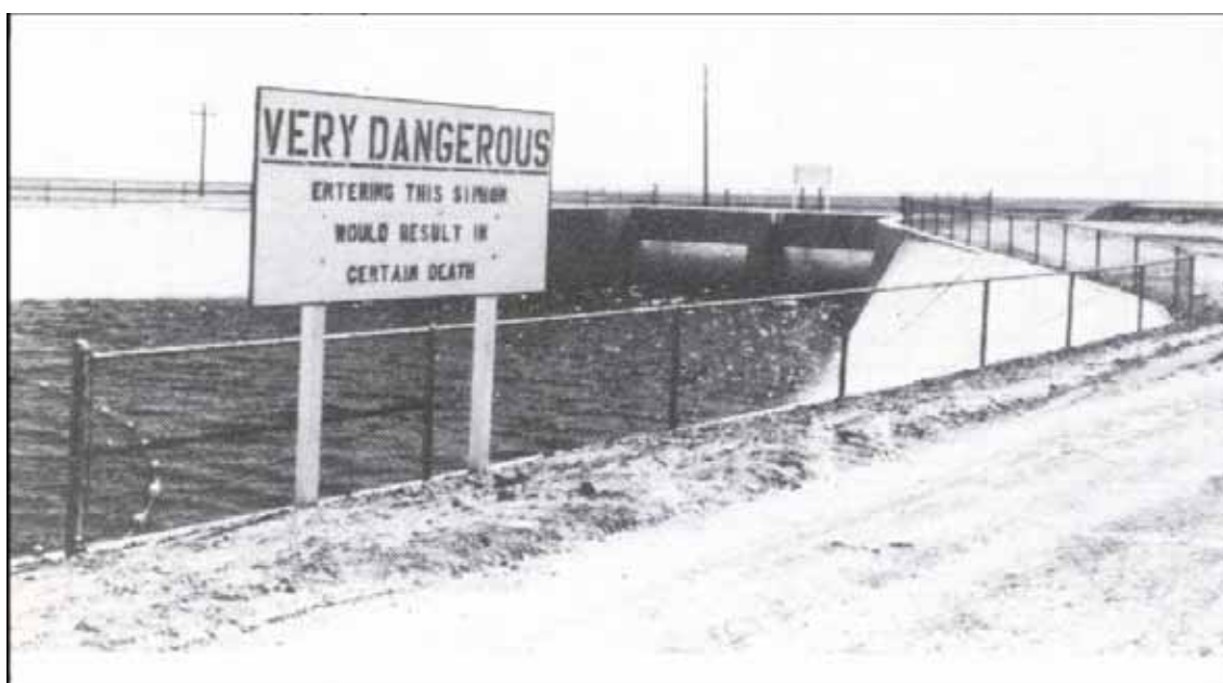
شکل ۳۱- تجهیزات ایمنی و علائم هشداردهنده در اطراف یک سازه سیفون (تور سیمی و کابل ایمنی)
