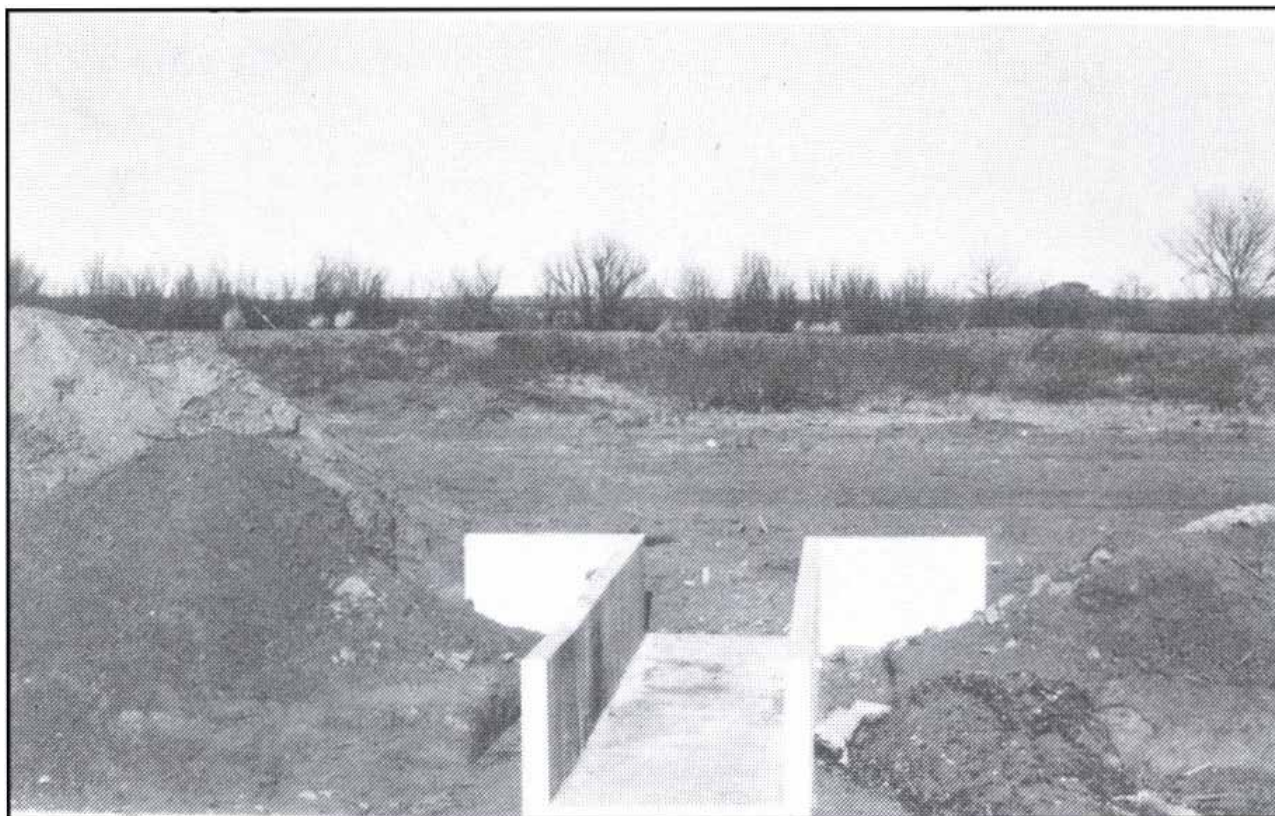
شکل ۲۲- ساختمان ورودی زهکش از نوع بتنی با مقطع راست گوشه در کانال با پوشش بتنی
