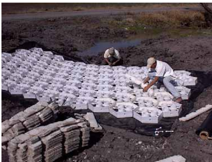
شکل ۳-۸- اجرای پوشش حاشیه رودخانه با قالب بندی پلاستیکی (بتن مشبک)
