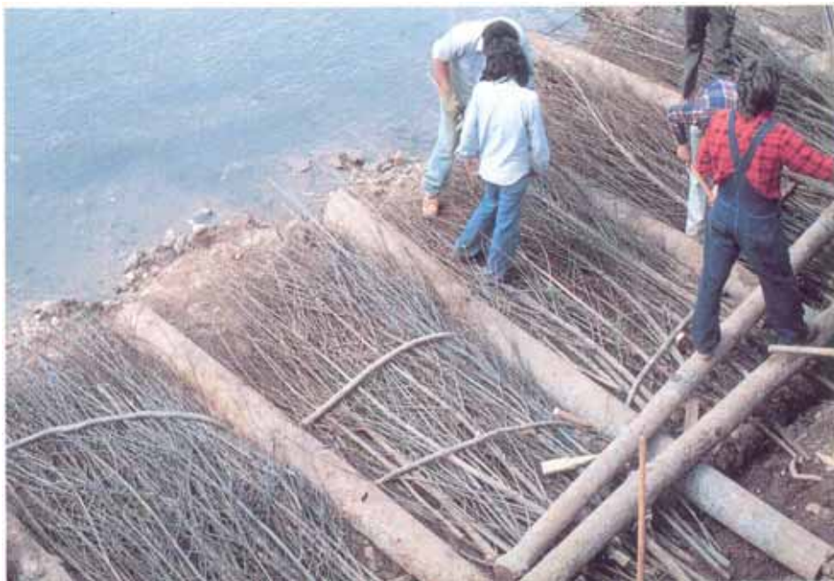
شکل ۹-۴- شکل دیگری از نوع استفاده از مواد گیاهی در حفظ دیواره‌ها
