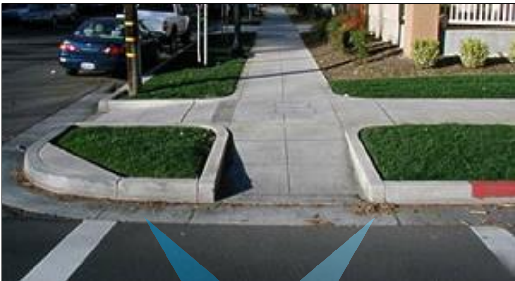
شکل ۴-۴- نمونه‌ای از یک رابط ترکیبی پیاده‌رو
