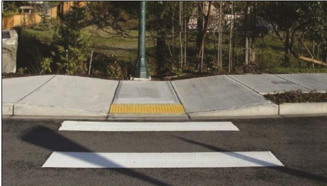
شکل ۳-۴- نمونه‌ای از یک رابط موازی پیاده‌رو
