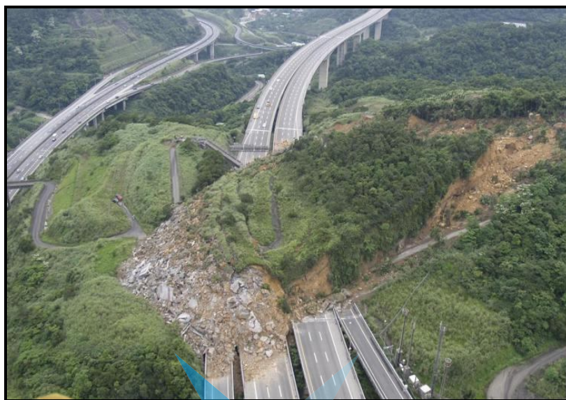
شکل ۱-۱۶- وقوع زمین لغزش ناشی از تحریک زلزله در شمال تایوان منجر به مسدود شدن اتوبان می‌شود [۲۷].
