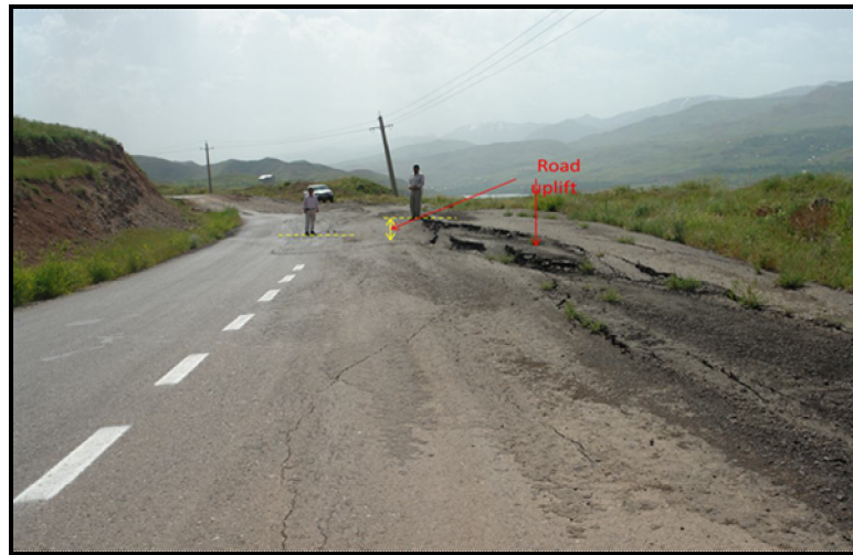
شکل ۲-۱۶- نمونه‌ای از تخریب به بار آمده توسط زمین لغزش دنبلید طالقان
