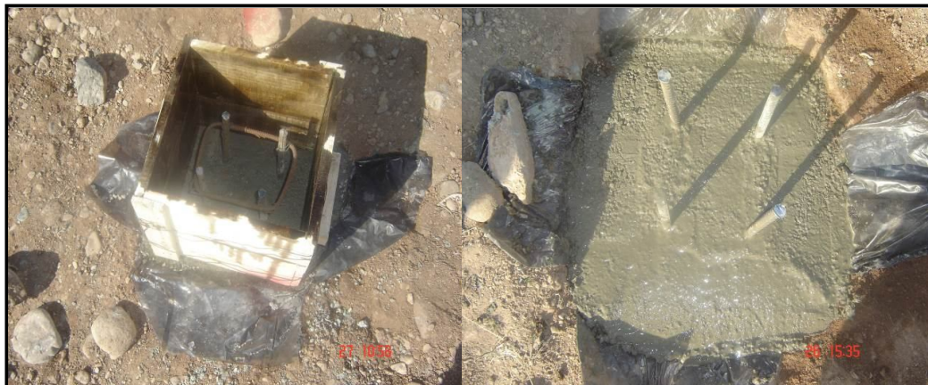
شکل ۲-۵۳- نمایی از نحوه آرماتوربندی و بتن‌ریزی ایستگاه‌ها
