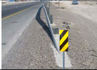
ب: بالی شکل کردن قسمت ابتدایی گاردریل
