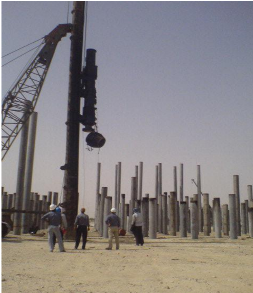
شکل الف-۲۶- رها شدن کلاهک از چکش به علت عدم رعایت ایمنی تجهیزات کوبش
