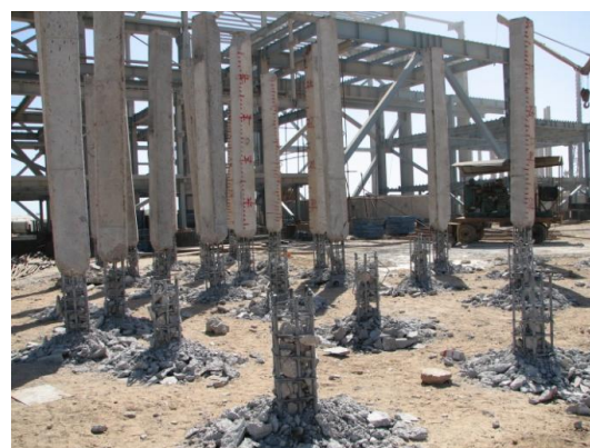
شکل الف-۱۱- بریدن راس شمع‌های بتنی با کمک تخریب (سمت راست) و توسط اره‌های مخصوص (سمت چپ)
