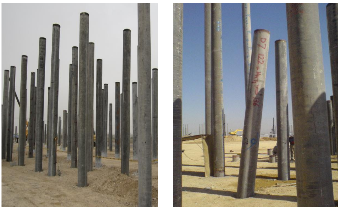
شکل الف-۹- در اشکال فوق به ترتیب تصاویری از یک شمع مردود و شمع‌های قابل قبول از لحاظ میزان انحراف از راستای کوبش (محور قائم) ارائه شده است.
