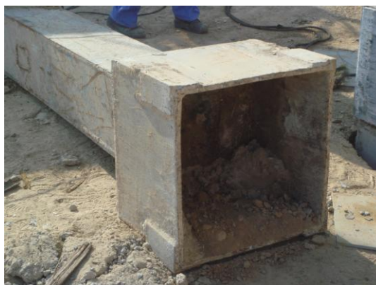
شکل الف-۴- نمونه‌ای از یک دنبالگر (Follower)
