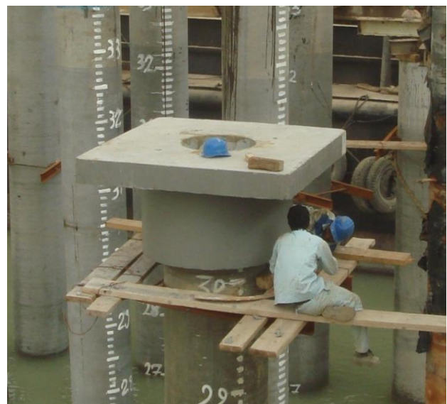
شکل الف-۲۷- عدم رعایت نکات ایمنی (تصویر سمت راست) در مقابل استفاده از کلاه و کمر بند ایمنی (تصویر سمت چپ)
