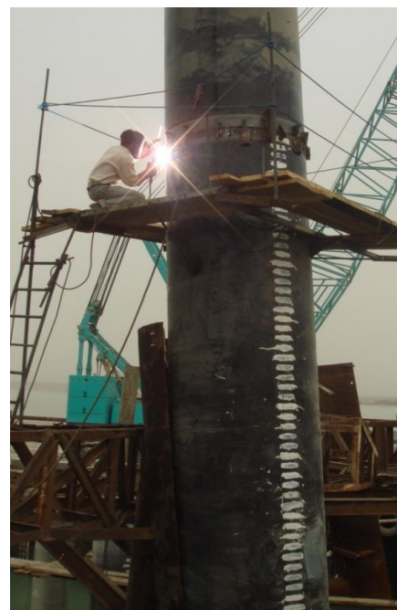
شکل الف-۶- جایجایی شمع از محل قلاب‌های تعبیه شده که کمترین لنگر ماکزیمم را ایجاد می‌نماید.
