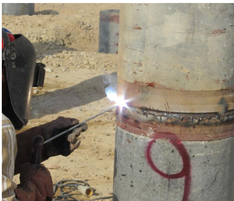
شکل الف-۷- تطویل شمع با اتصال جوشی
