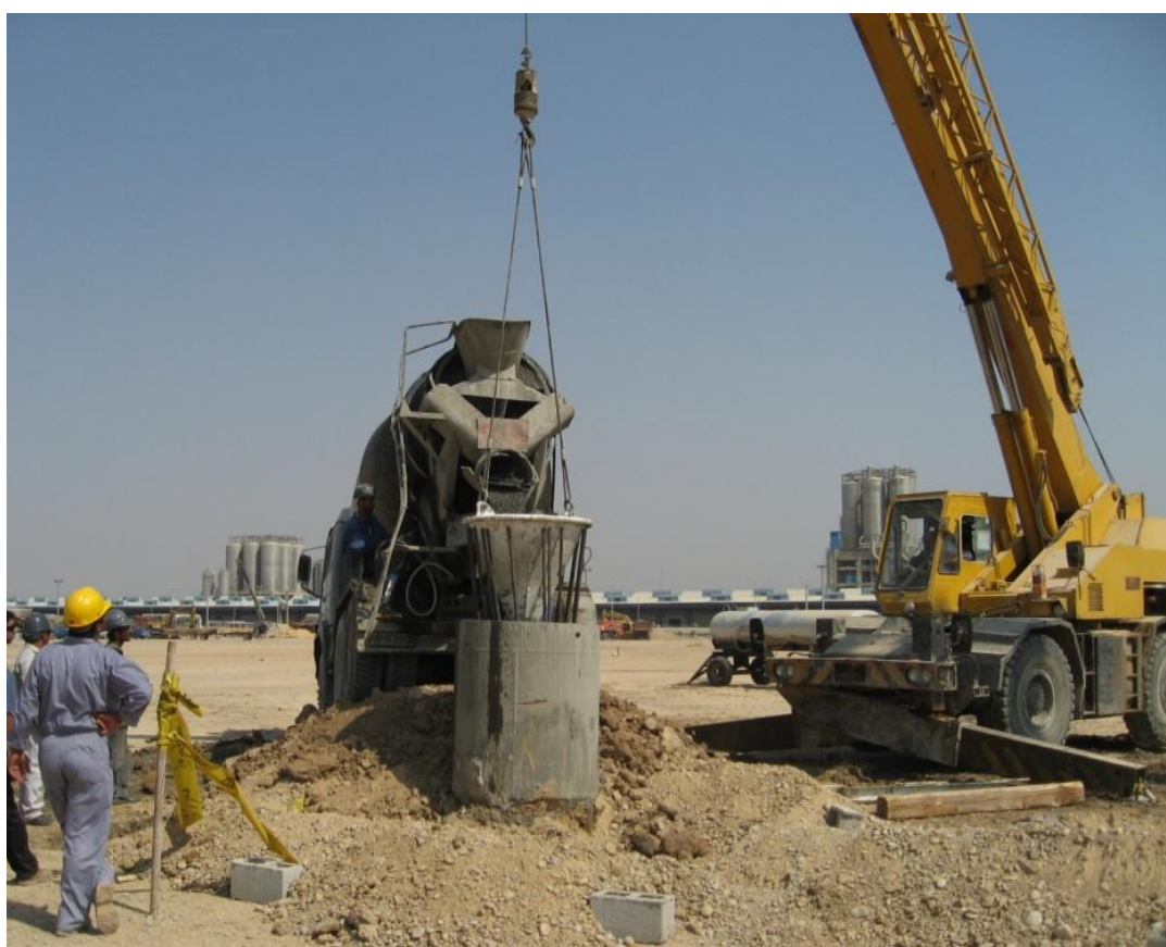
شکل الف-۱۷- بتن‌ریزی درون شمع درجاریز توسط لوله ترمی
