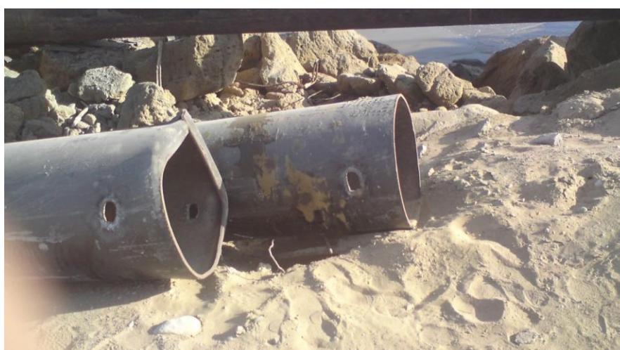
شکل الف-۱۲- آسیب دیدگی راس شمع فولادی توسط کوبش نامناسب
