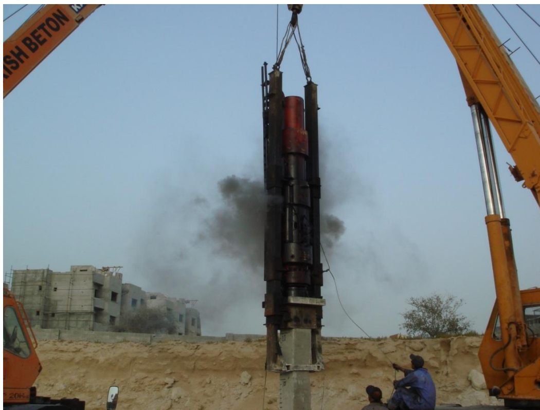
شکل الف-۲۴- انجام عملیات کوبش شمع در محیط‌های شهری باعث آلودگی‌های صوتی و زیست محیطی می‌گردد.
