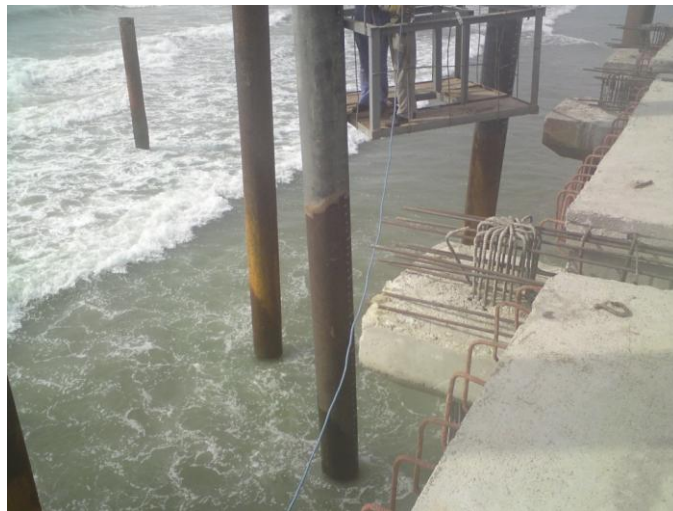
شکل الف-۱۴- بالا ماندن قسمت محافظت شده به علت عدم تعیین صحیح طول قابل کوبش شمع ها
