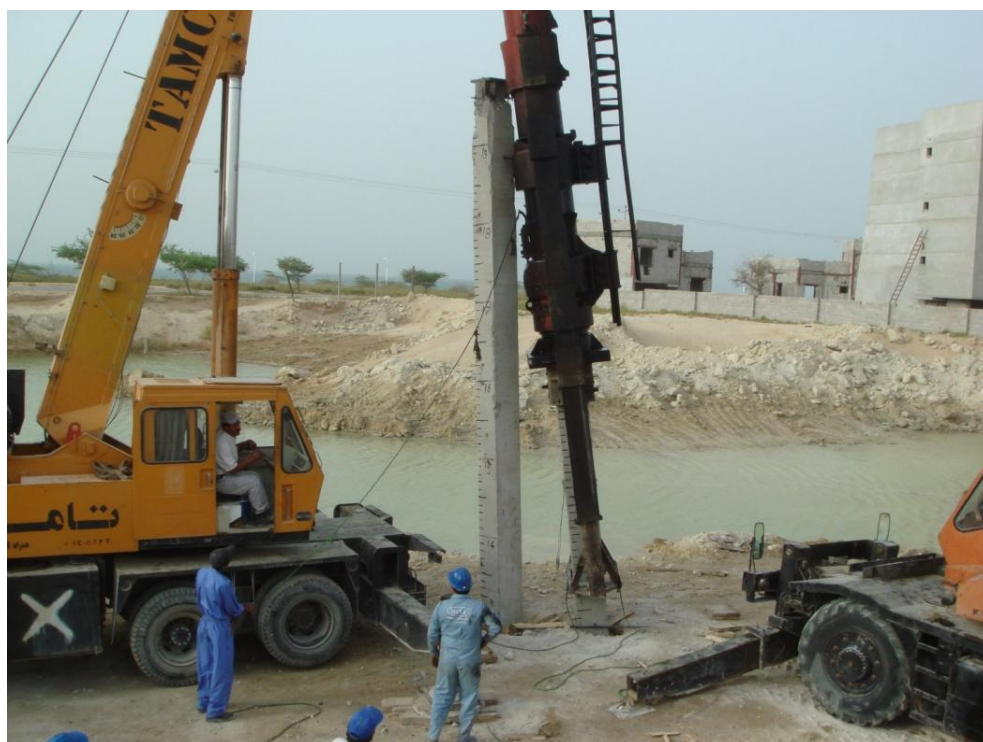
شکل الف-۲۵- شکستگی شمع در اثر عدم ایمنی سیستم کوبش و واژگونی چکش
