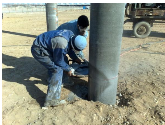
شکل الف-۱۱- بریدن راس شمع‌های بتنی با کمک تخریب (سمت راست) و توسط اره‌های مخصوص (سمت چپ)
