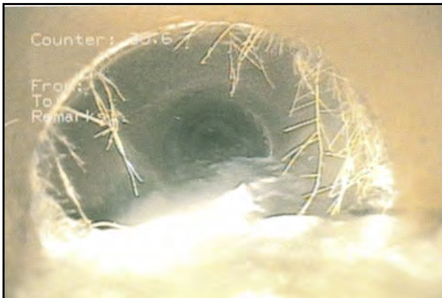
شکل ۶-۱۱-الف- نفوذ ریشه‌های نازک از میان اتصالات (RF)
