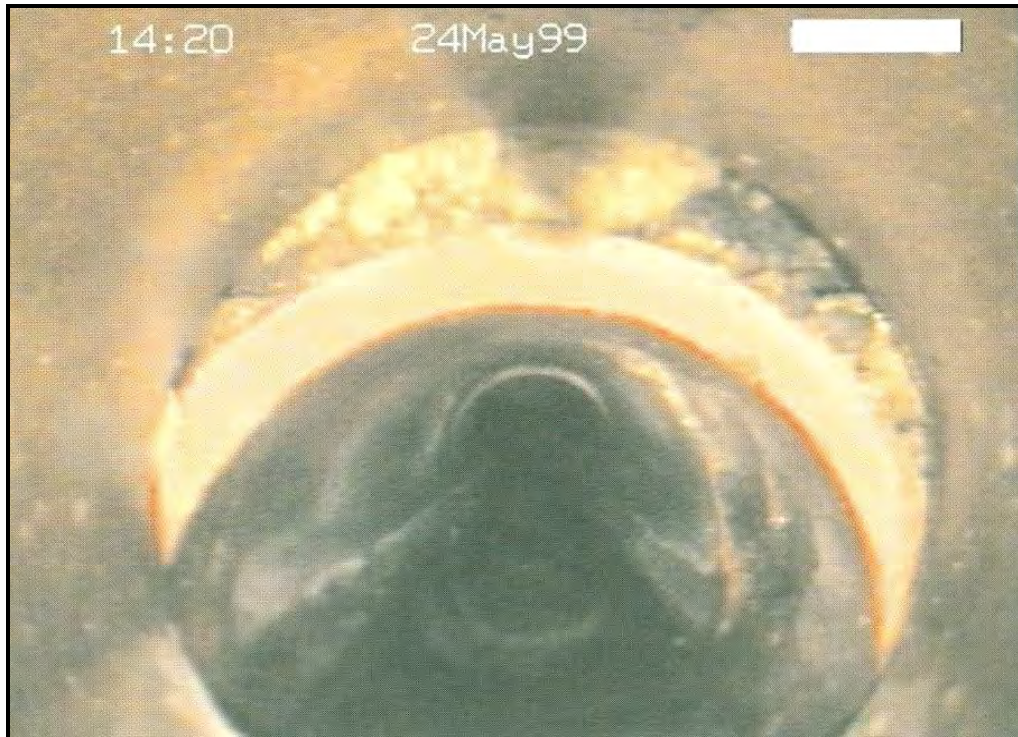
شکل ۶-۸-ب - جابجایی در محل اتصال
