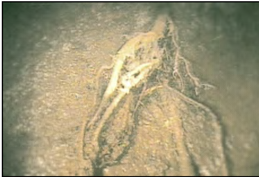
شکل ۶-۱۱-ب- نفوذ تک‌ریشه ضخیم با ضخامت بیش از ۱۰ میلی‌متر به فاضلابرو (RT)
