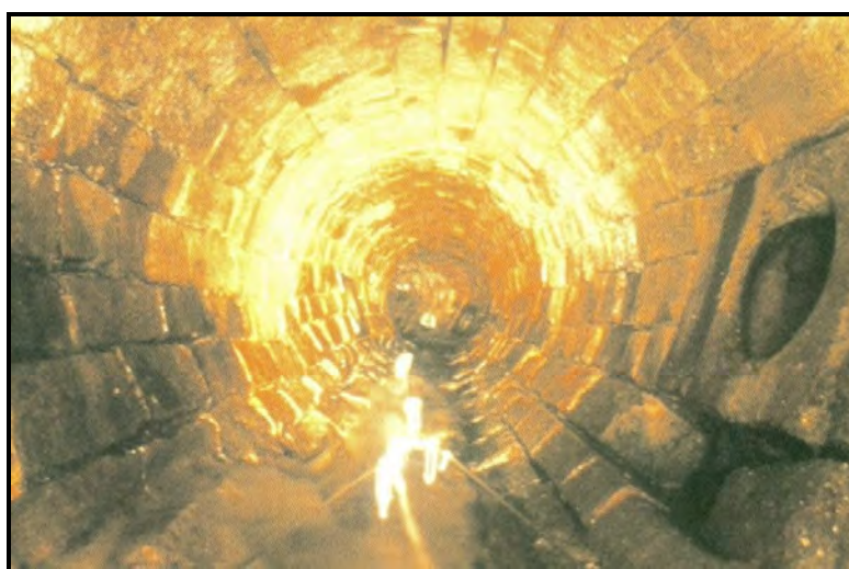
شکل ۶-۲۰-ج - اتصال معیوب فاضلابروی جانبی در موقعیت ساعت ۲
