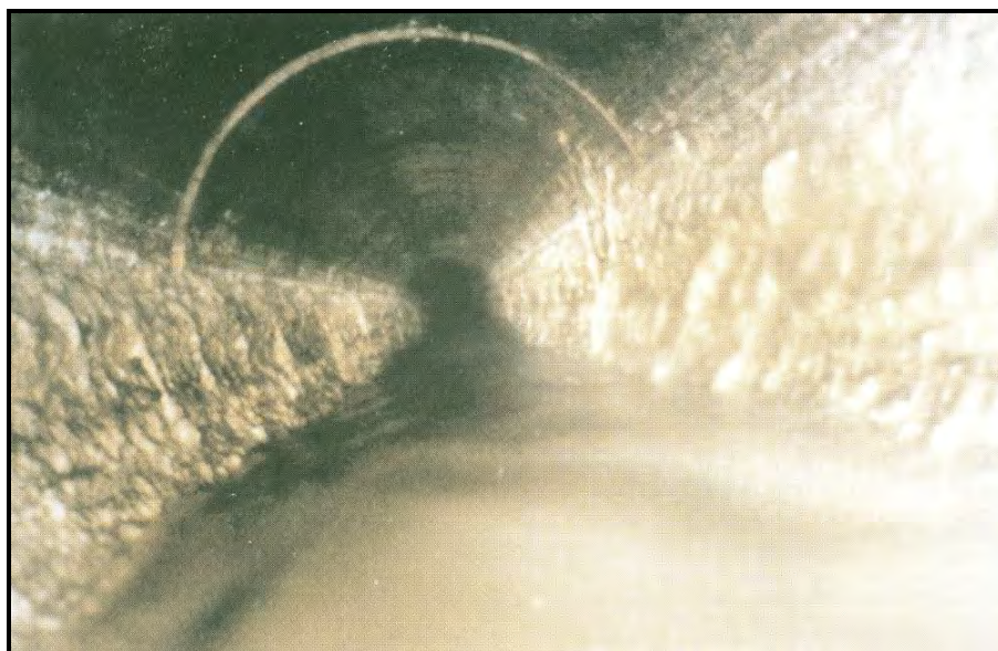
شکل ۶-۱۴-ج- رسوبات چسبیده از نوع گریسی از ساعت ۲ تا ساعت ۴ و از ساعت ۸ تا ساعت ۱۰
