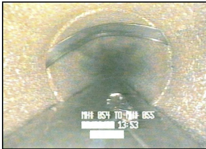
شکل ۶-۲۱- ورود واشر آب‌بند به فضای داخل لوله (SR)، از ساعت ۹ تا ۲
