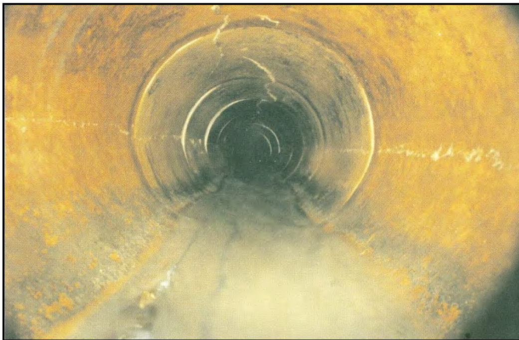
شکل ۶-۲- الف- ترک‌های طولی (CL) در ساعت ۹ و در ساعت ۳
