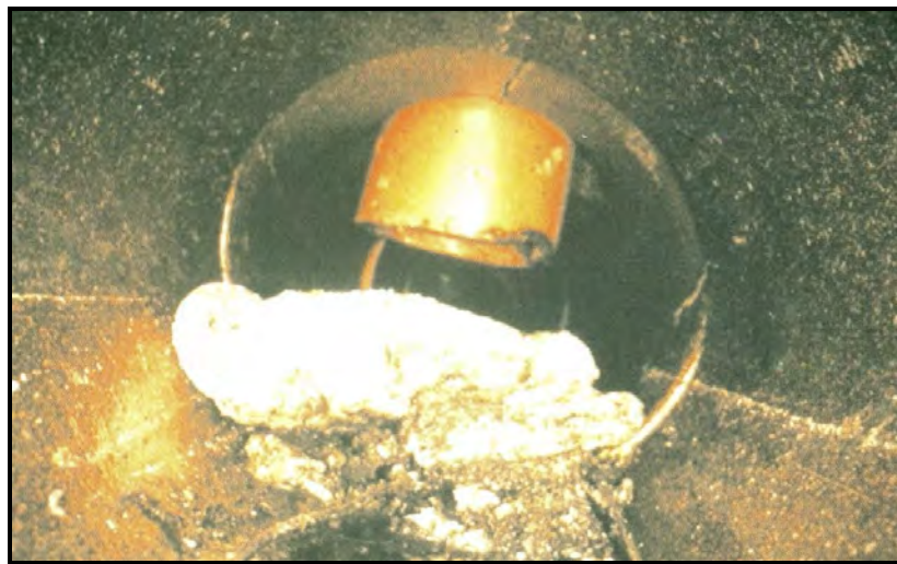
شکل ۶-۲۰-الف- انشعاب مهاجم (Intruding Connection) در ساعت ۱۲
