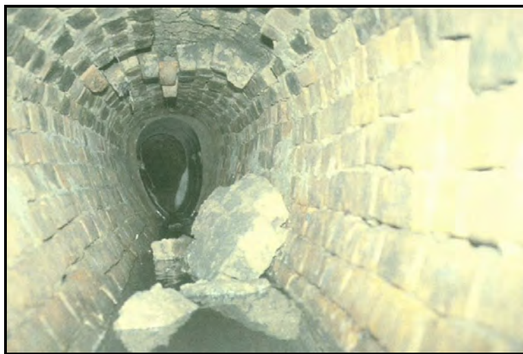
شکل ۶-۱۷-ب - وجود مانع در کف فاضلابرو از نوع آجر یا سایر مصالح بنایی
