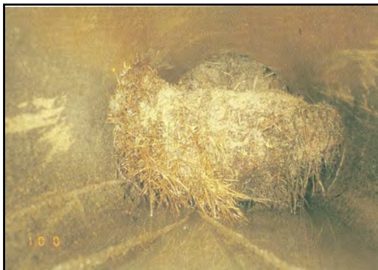
شکل ۶-۱۱-ج- نفوذ انبوه ریشه‌ها (RM) به داخل فاضلابرو و ۷۵٪ کاهش سطح
