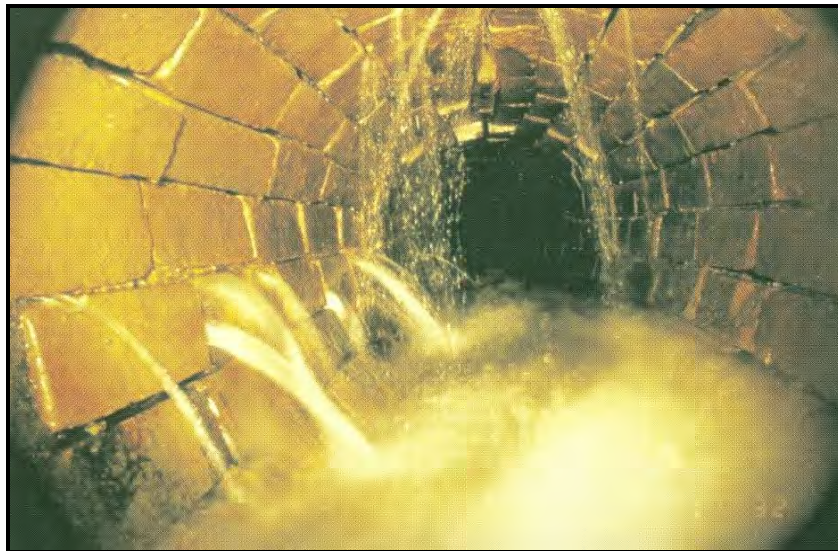
شکل ۶-۱۲-ج- نشتاب از نوع جریان‌دار (IR) از ساعت ۱۱ تا ساعت ۱ و فوران نشتاب (Gushing Infiltration) از ساعت ۸ تا ساعت ۹
