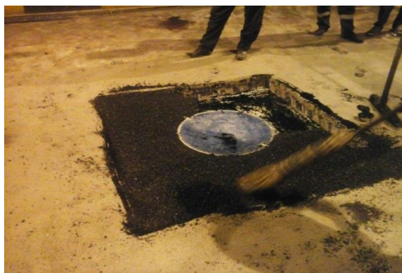
شکل شماره (۲۱): نمایی از مرمت آسفالت اطراف دریچه منهول
