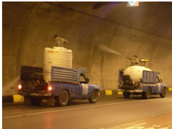
شکل شماره (۱۹): نمایی از شستشوی دیواره تونل
