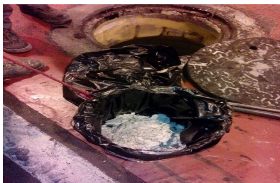
شکل شماره (۱۸): نمایی از لایروبی منهول‌ها
