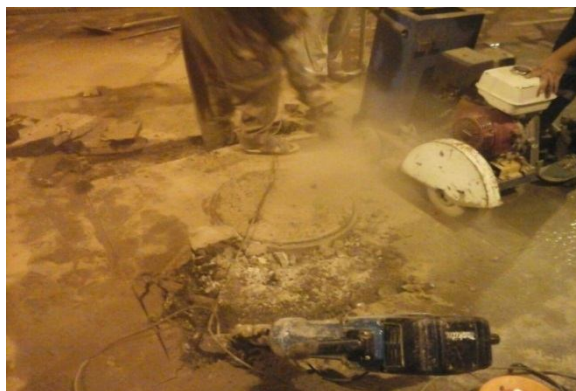
شکل شماره (۲۰): نمایی از تعمیر و رفع ایراد دریچه منهول معیوب در تونل
