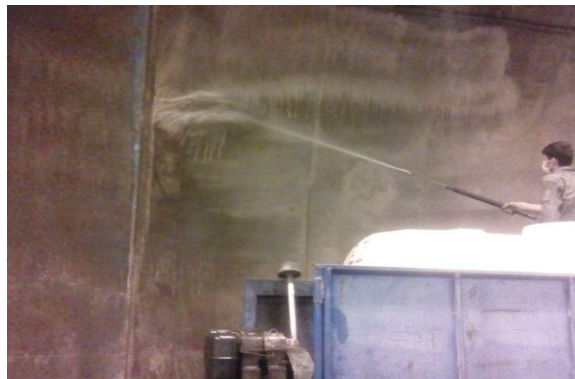
شکل شماره (۵): نمایی از شستشوی دیواره تونل توسط واتر جت
