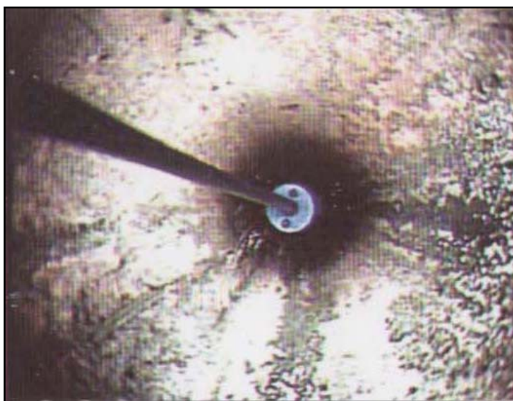
شکل ۴-۱۴- انسداد شبکه‌های لوله جدار
