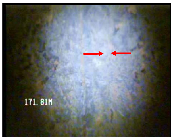
شکل پ.۱-۴- تصویر عملیات ویدئومتری سطح استاتیک ۱۷۱/۸۱ متر
