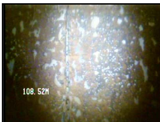
شکل پ.۱-۱۱- تصویر حاصل از ویدئومتری در عمق ۱۰۸/۵۲ متری
