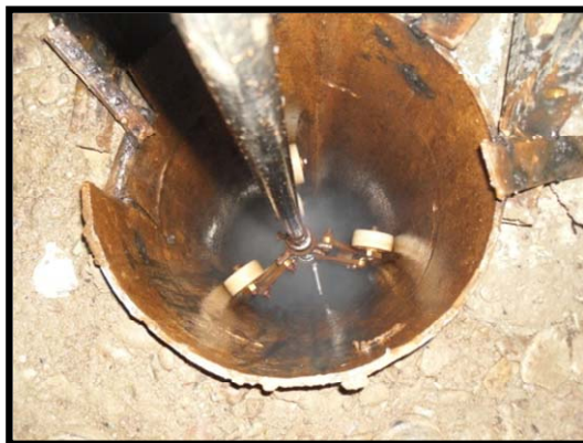
شکل پ.۱-۷- تصویر داخل چاه
