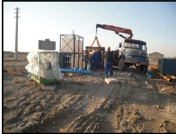
شکل پ.۱-۵- عملیات پاکسازی و فعال‌سازی چاه
