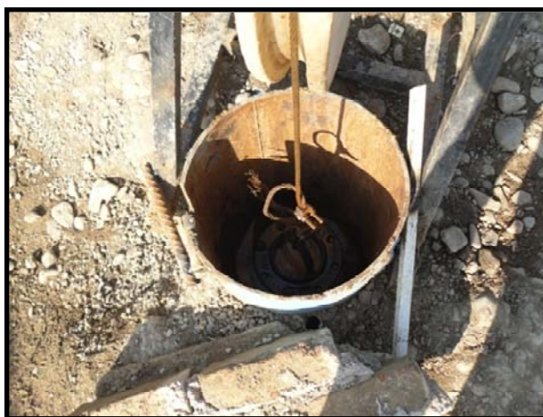
شکل پ.۱-۱۴- عملیات اسیدشویی چاه
