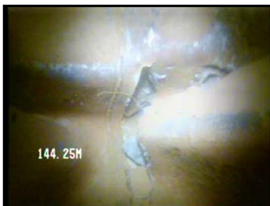
شکل پ.۱-۱۰- تصویر حاصل از ویدئومتری در عمق ۱۴۴/۲۵ متری
