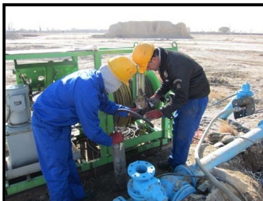
شکل پ. ۱-۱۲- احیای چاه به وسیله ضربات هوا
