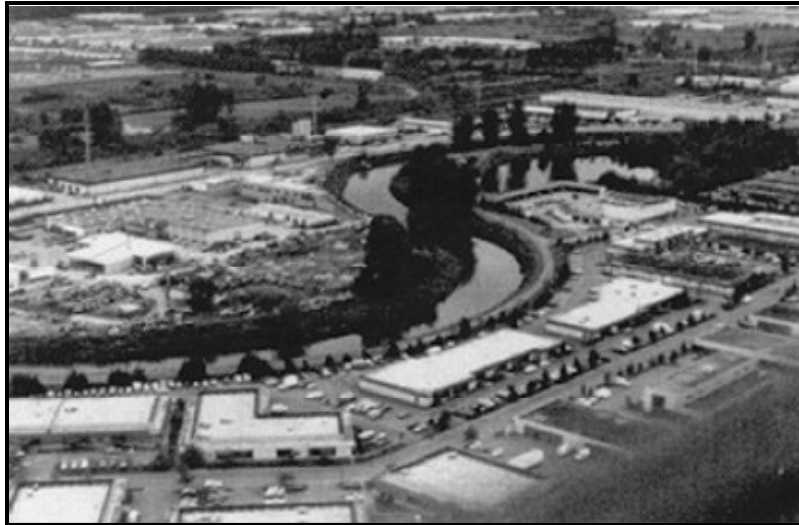
شکل ۶-۶- احداث گوره در طرفین کانال رودخانه با حفظ شکل پیچانرودی آن [۷۲]
