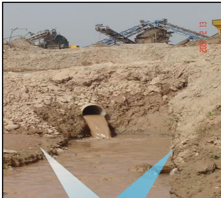
شکل ۳-۲- تخلیه پساب عملیات برداشت در کارگاه
