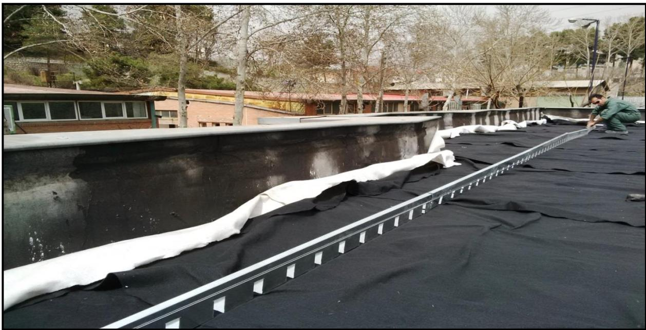
شکل پ.۱۰-۱- قرار دادن جداکننده‌های گالوانیزه در امتداد حدفاصل مسیر حرکت و فضای سبز؛ قطعات ساخته شده در یک دیگر فرو رفته و یک امتداد را شکل می‌دهند.
