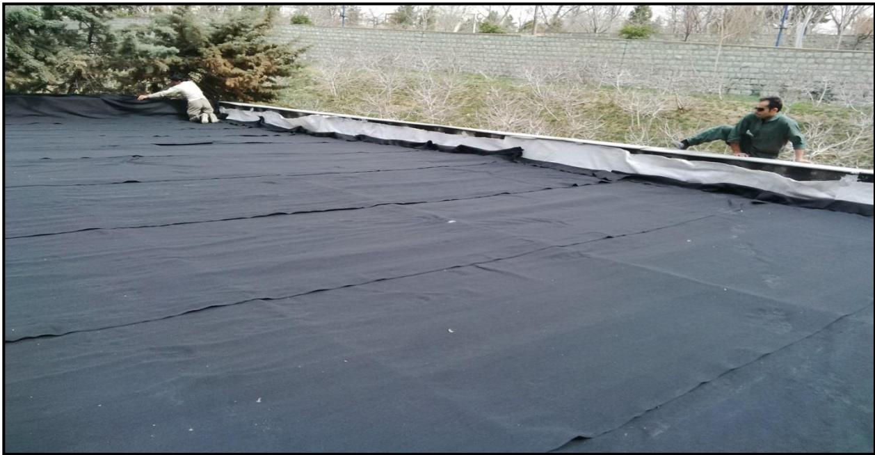
شکل پ.۹-۱- قرار دادن لایه ژیوتکستایل صافی؛ پهن کردن این لایه با هم پوشانی ۱۰ سانتی‌متری بر روی سقف صورت می‌گیرد. این لایه در بدنه عمودی جان‌پناه امتداد می‌باید و توسط توری ثابت شده و روی آن ملات ماسه سیمان اجرا می‌شود.
