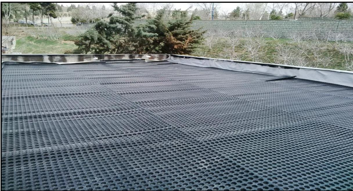
شکل پ.۷-۲- قراردادن لایه زهکش؛ پهن کردن این لایه با همپوشانی ۱۰ سانتی‌متری بر روی سقف صورت می‌گیرد. برای این منظور حفره‌ها در یکدیگر جاگیر می‌شوند.
