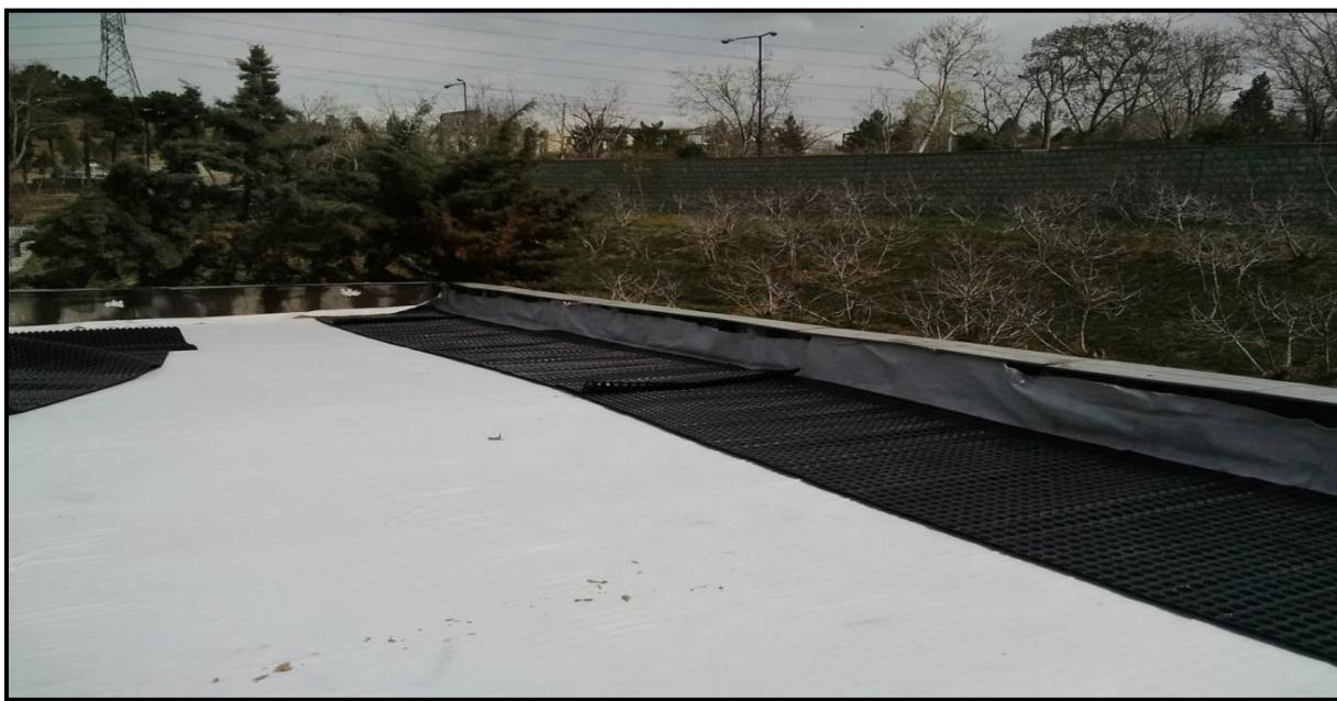
شکل پ.۷-۱- قرار دادن لایه ژیوتکستایل جداگانه؛ پهن کردن این لایه با همپوشانی ۱۰ سانتی‌متری بر روی سقف صورت می‌گیرد. این لایه در بدنه عمودی جانپناه امتداد می‌یابد.
