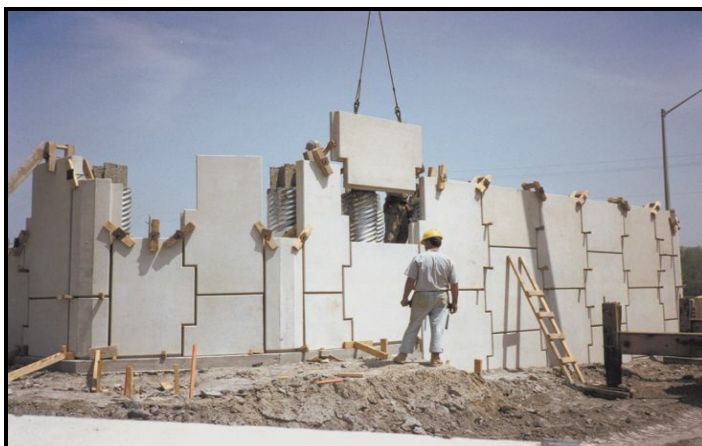
شکل ۱۲-۴- اجرای دیوار خاک مسلح با نمای بتنی
