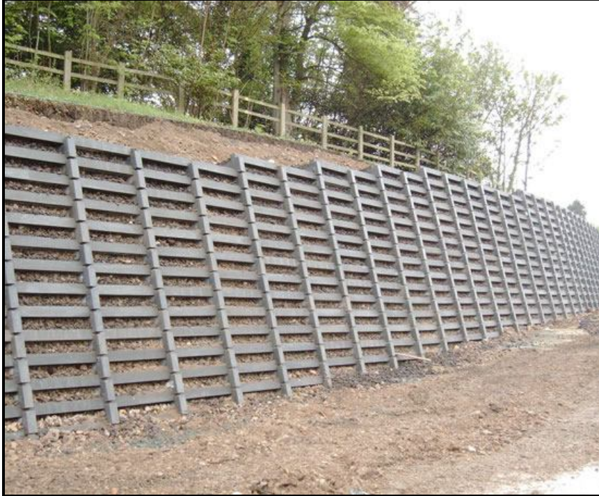
شکل ۱۱-۸ - نمونه‌ای از دیوار حائل صندوقه‌ای اجرا شده
