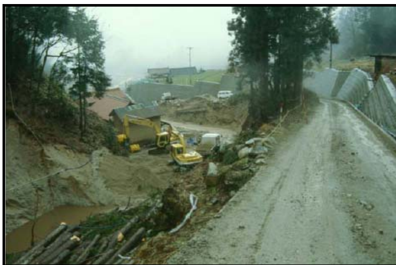
شکل ۶-۵- یک دیوار حایل منحرف‌کننده مواد واریزه‌ای در راس مخروط یک جریان واریزه‌ای نزدیک هیروشیمای ژاپن
