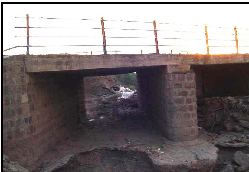
شکل ۷-۱۹- آبخستگی شدید در بستر و تخریب پی در محل پایه‌ها در مسیل فروان
