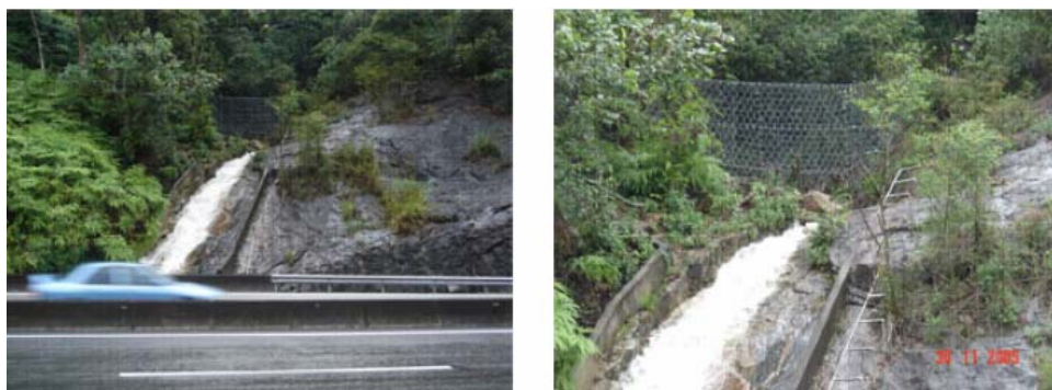
شکل ۶-۲- نمونه‌ای از توری نگهداشت مواد واریزه در بالادست جاده
