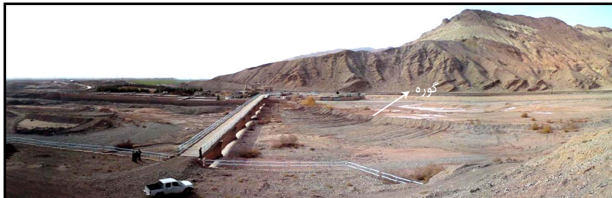
شکل ۷-۱۶- عکس پوششی سد انحرافی گرمسار (به محل گوره‌ها در بالادست سد توجه کنید)
