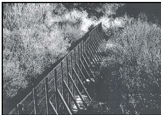
شکل ۶-۳- دیوار مانع واریزه در کالیفرنیا جنوبی [۹۹]
