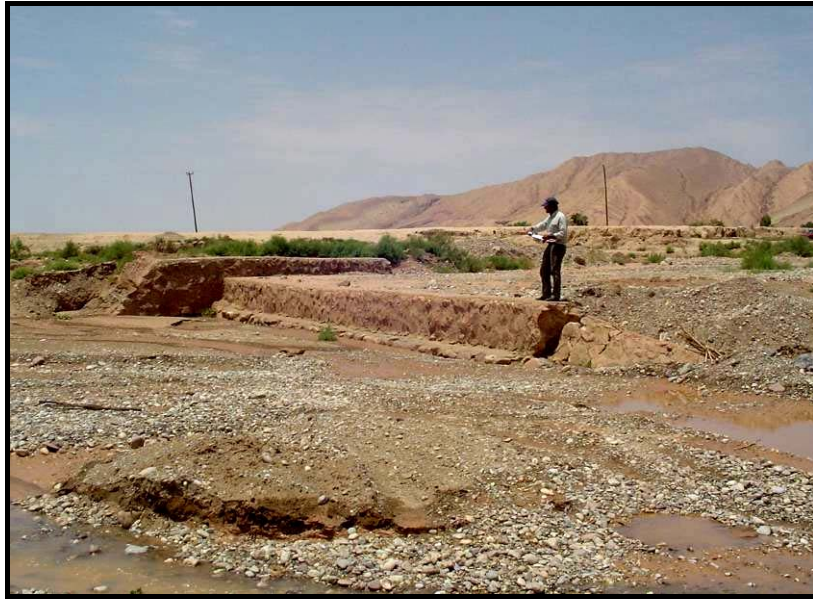
شکل ۷-۲۰- رسوب‌گذاری در پایین دست سد اصلاحی در مسیل سوداغلان
