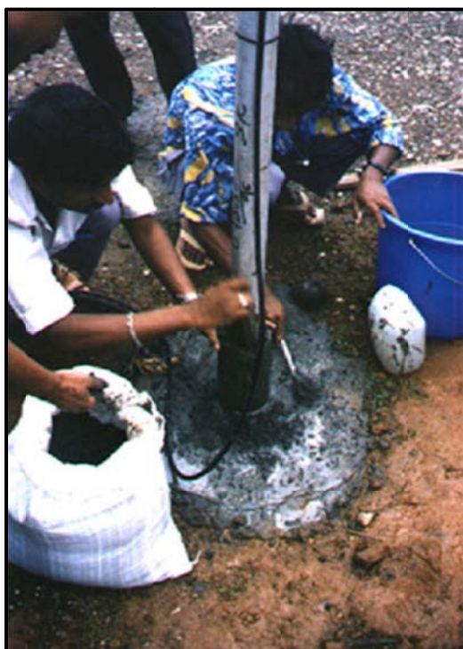
شکل ۳-۴۸- نصب تیرک بر پایه‌ی ستونی
