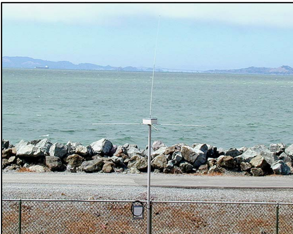
شکل ۳-۴۷- آنتن نصب شده روی حصار
