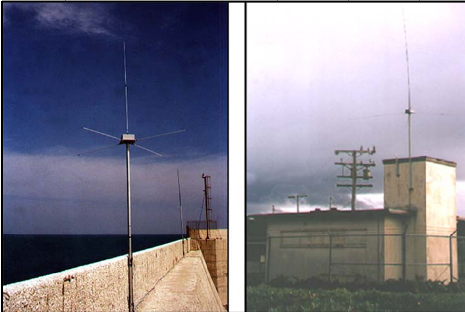
شکل ۳-۴۶- نصب آنتن روی دیوار و ساختمان
