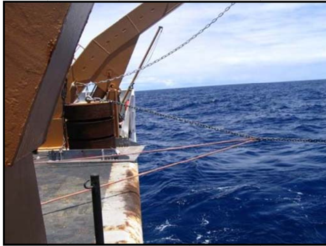
شکل ۳-۷۶- دو بند قرمز رنگ، به دور رها ساز صوتی متصل می‌شود که ریسمان گوی شناور را به لنگر متصل نماید
