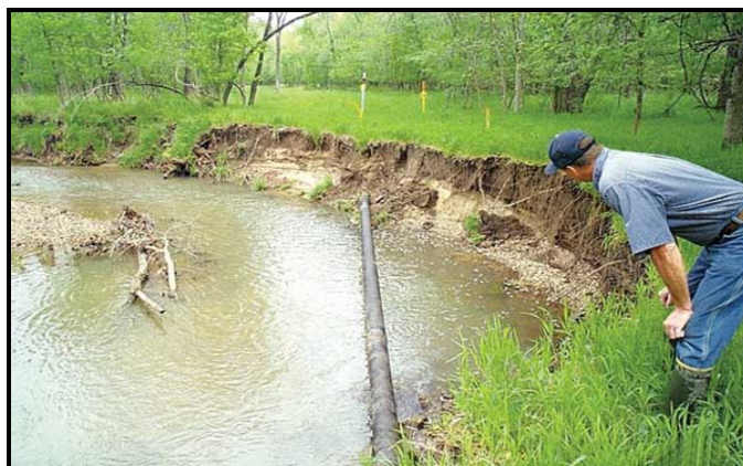
شکل ۱-۳- فرسایش جداره و بستر رودخانه در محل قوس یک رودخانه
