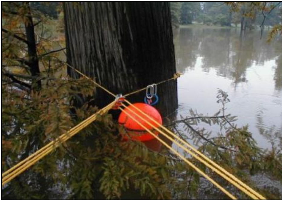
شکل پ.۴-۴۴- استفاده از تکیه‌گاه‌های طبیعی برای نصب بوم‌ها در مناطق ساحلی
