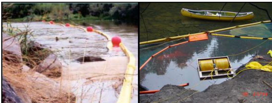
شکل پ. ۴-۳۱- تکنیک به کارگیری بوم‌ها برای تغییر مسیر لکه نفت به منطقه خاص و جمع‌آوری نفت
