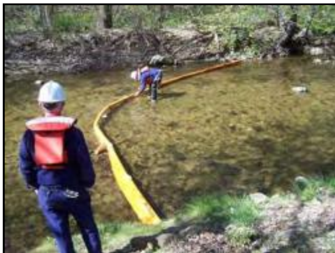
شکل پ. ۴-۲۶- به‌کارگیری بوم‌ها در نهرهای کوچک برای محدودسازی جریان نفت شناور
