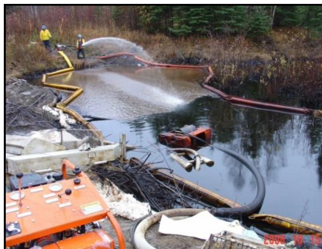
شکل پ.۴-۱۲ - محدود کردن آلودگی نفتی در یک منطقه خاص با کمک فشار آب
