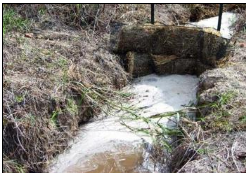
شکل پ.۴-۹- استفاده از حصارهای فلزی و گیاهان برای جلوگیری از گسترش آلودگی
