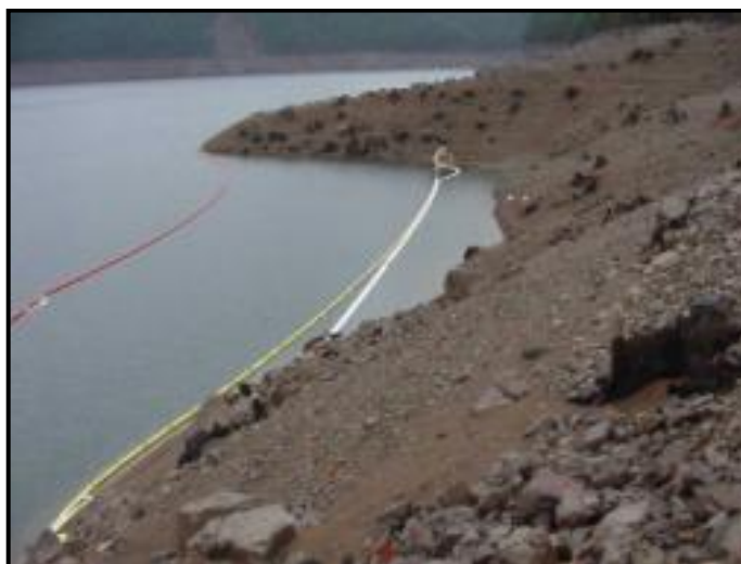
شکل پ. ۴-۲۷- به‌کارگیری بوم‌ها در نهرها و رودخانه‌های بزرگ برای محدودسازی جریان نفت شناور
