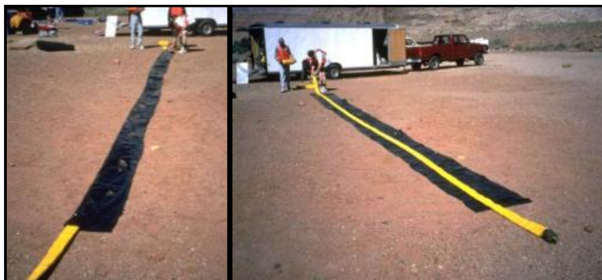
شکل پ.۴-۵- نمونه‌ای از ایجاد بوم با استفاده از حداقل تجهیزات در اختیار (نایلون و شلنگ آتش‌نشانی)
