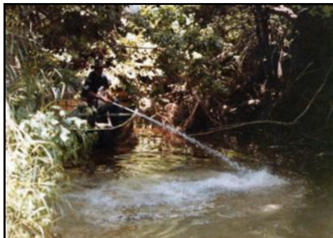
شکل پ.۴-۱۱ - محدود کردن آلودگی نفتی در یک منطقه خاص با کمک فشار آب
