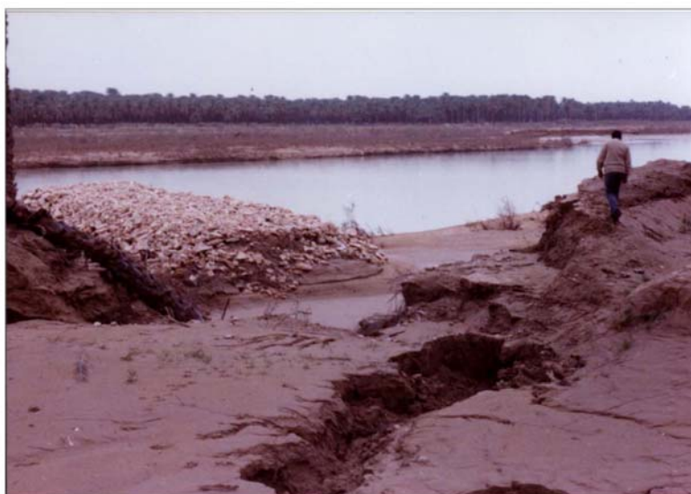
شکل ۸-۶- تخریب ریشه آبشکن در اثر انحراف سیلاب اسفند ۱۳۶۵، رودخانه حله، برازجان [۴۵]
