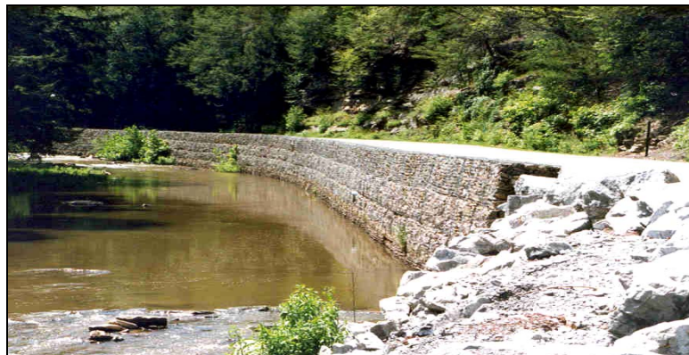
شکل ۵-۵- اجرای توری سنگ جهت حفاظت دیواره رودخانه
