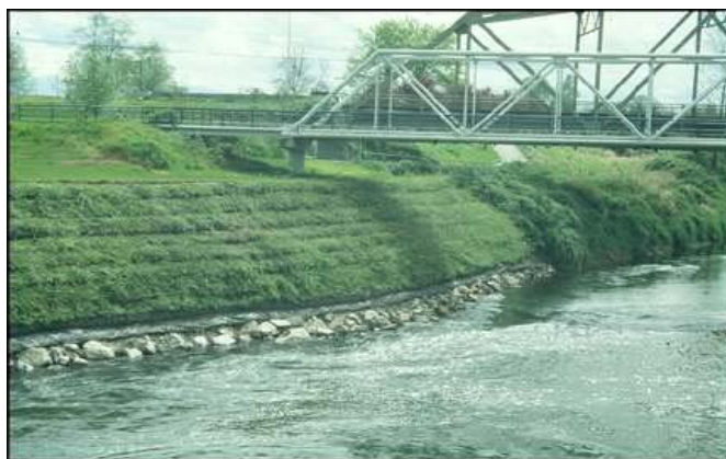
شکل ۵-۶-الف- پوشش گیاهی اجرا شده برای حفاظت دیواره رودخانه
