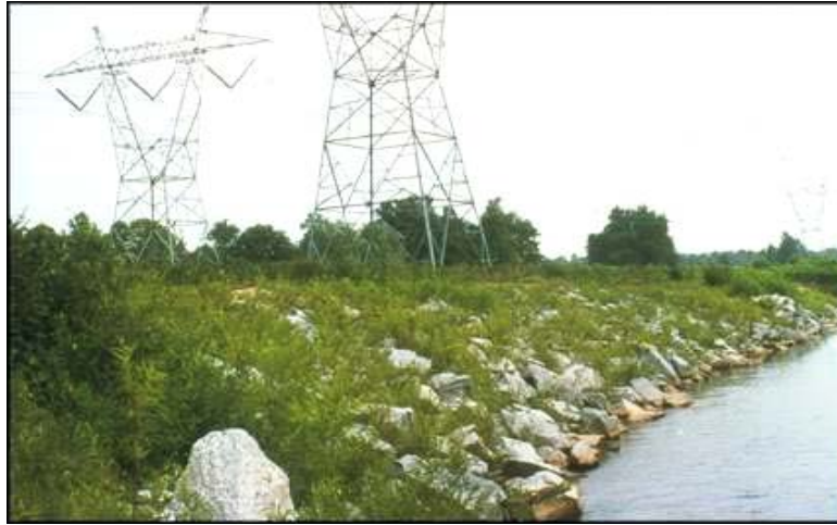
شکل ۵-۶-ب- استفاده از ترکیب سنگریز و پوشش گیاهی جهت حفاظت دیواره رودخانه
