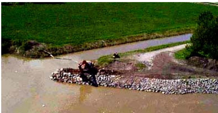
شکل ۵-۱- استفاده از پوشش سنگی جهت حفاظت دیواره در آبگیر مستقیم
