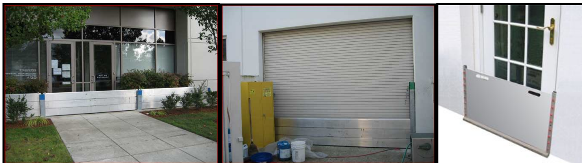
شکل ۵-۸- نمونه‌ای از سپرهای آب‌بندی که در هنگام هشدار سیل نصب می‌شود [۶۴]
