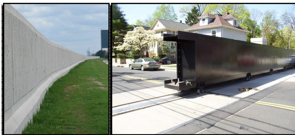
شکل ۳-۵- نمونه‌ای از دیواره‌های فولادی و بتنی اجرا شده برای پادسیل‌سازی
