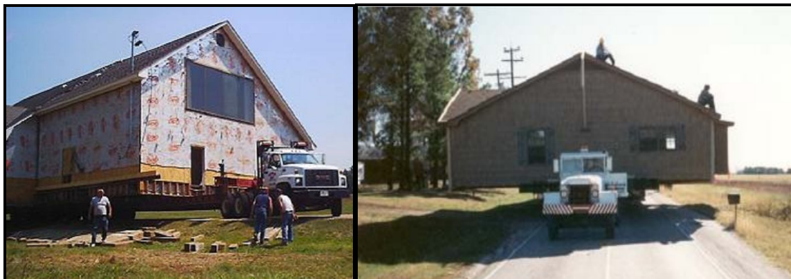
شکل ۵-۴- نمونه‌ای از اجرای تغییر مکان ساختمان موجود [۵۶]
