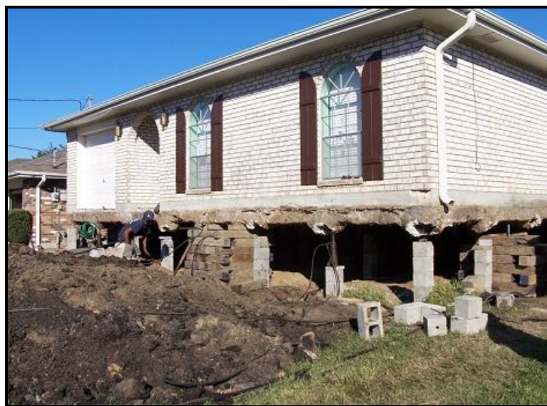
شکل ۵-۱- نمونه‌ای از اجرای مرتفع‌سازی ساختمان موجود [۵۶]
