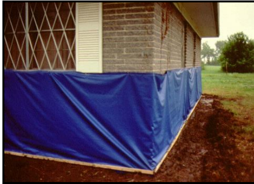
شکل ۵-۶- نمونه‌ای از انجام آب‌بندی دیوارهای ساختمان به وسیله پارچه‌های ضد آب [۶۴]
