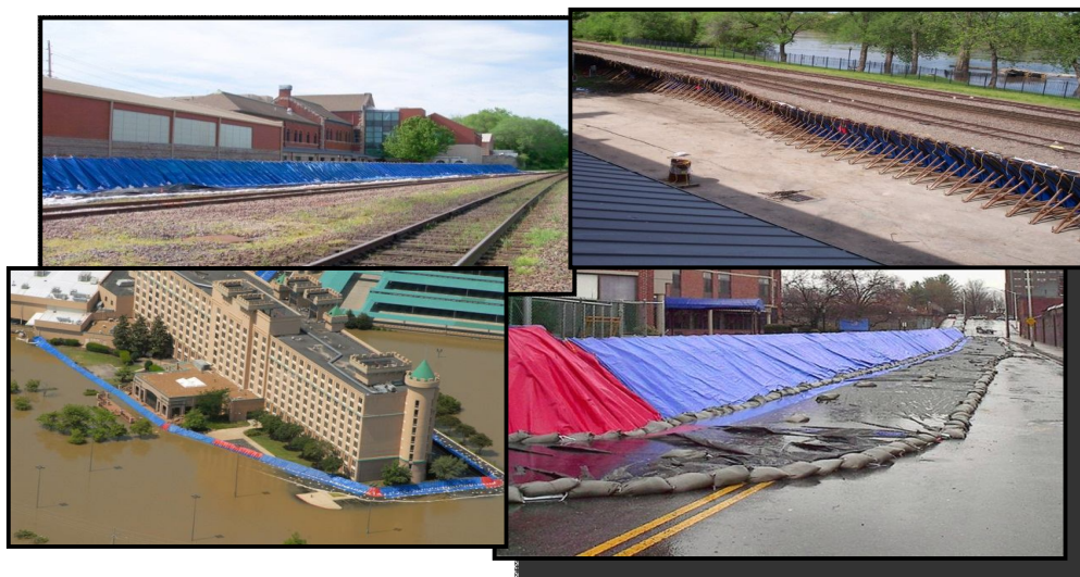
شکل ۳-۹- استفاده از پارچه‌های ضدسیلاب به عنوان کمک کننده (پوشش‌دهنده خاکریزها) [۴۷]
