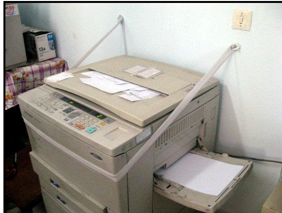
شکل ۴-۱۷- مهار مناسب دستگاه فتوکپی در مدرسه
