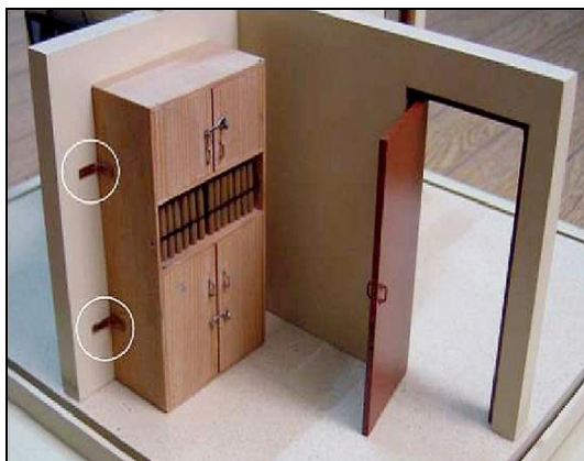
شکل ۴-۵- قفسه مهار شده در حین وقوع زلزله
