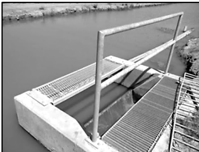
شکل ۳-۳۳- سرریز تخلیه در بازه کانال پایین‌دست ایستگاه پمپاژ که آب را به ورودی بازه کانال هدایت می‌کند
