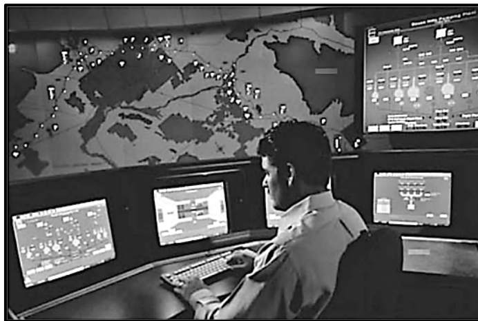
شکل ۵-۲- یک نمونه از ایستگاه مرکزی اسکادا و میزکار اپراتور
