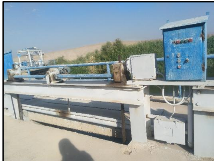
شکل ۳-۲۰- مجموعه عمل‌گر (در سمت راست) برای دریچه کشویی در شبکه ورامین
