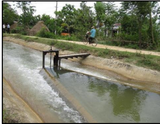
شکل ۳-۱۶- سرریز لبه طولانی از نوع نوک‌مرغابی
