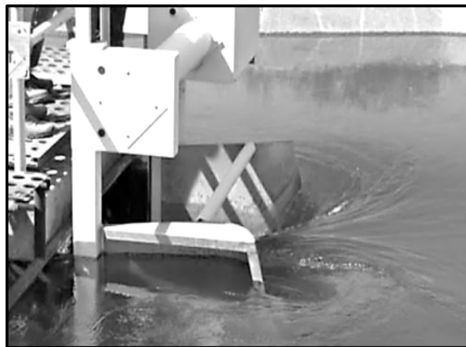
شکل ۳-۲۷- همگرایی و نوسان آب در ورودی یک دریچه، محدوده غیرمجاز نصب و استقرار حس‌گر
