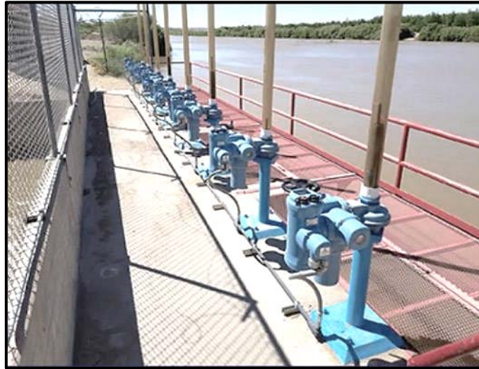
شکل ۳-۱۹- عمل‌گرهای دریچه‌های کشویی در ورودی مخزن تنظیمی
