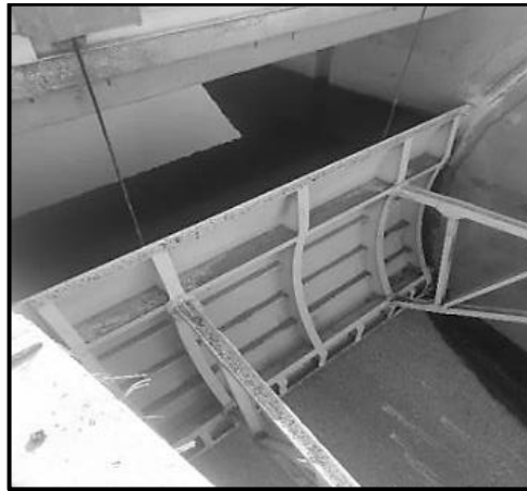
شکل ۳-۱۳- دید پایین‌دست دریچه‌های قطاعی - شبکه آبیاری ورامین
