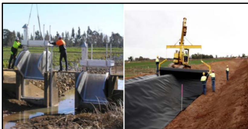
شکل پ.۱-۳- نمونه‌ای از پوشش‌دهی کانال خاکی و نصب سازه‌های تنظیمی عرضی (فلوم-دریچه) در طرح NVIRP، استرالیا
