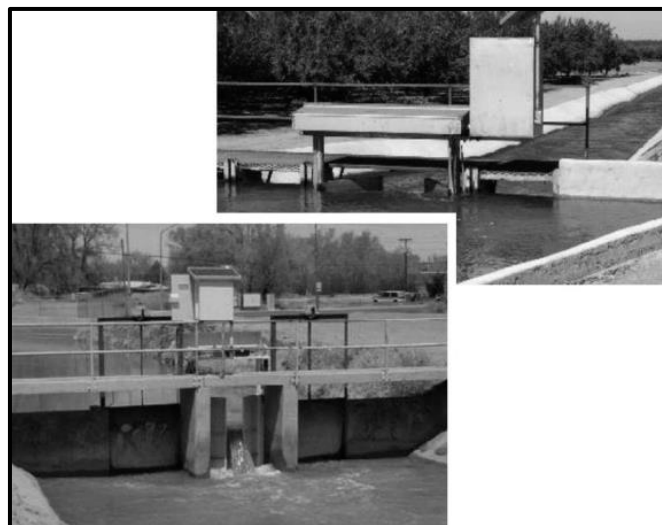
شکل ۳-۱۴- دید بالادست و پایین‌دست دریچه سالونی
