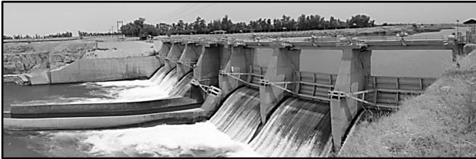
شکل ۳-۱۲- دریچه‌های قطاعی در سد تنظیمی دز
