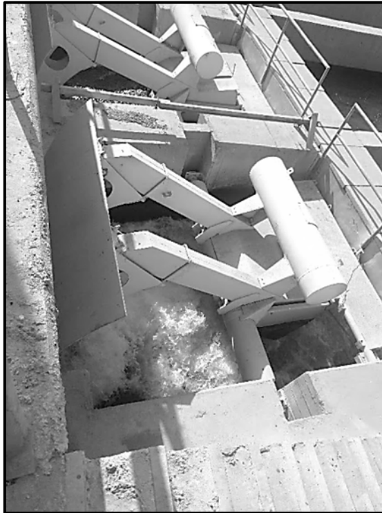
شکل ۳-۱۷- دریچه‌های آویس در شبکه آبیاری ورامین
