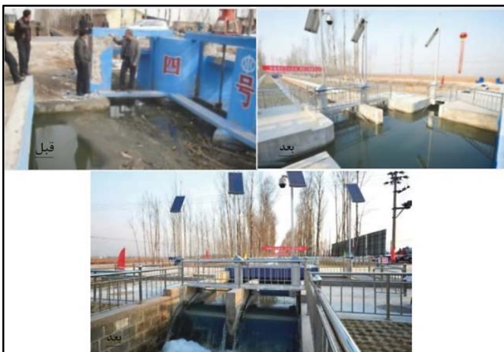
شکل پ. ۱-۹- تعویض دریچه‌های قدیمی با دریچه‌های خودکار در رودخانه فن، چین
