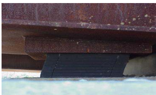
تکیه‌گاه تغییر شکل پیدا کرده است. با این وجود شرایط آن نسبتاً مناسب می‌باشد.
