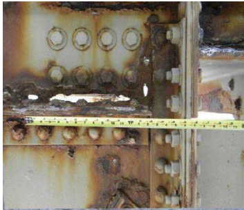
خوردگی بسیار شدید در تیر اصلی در محل اتصال رخ داده است. قسمتی از مقطع تیر به طور کامل از بین رفته است.
