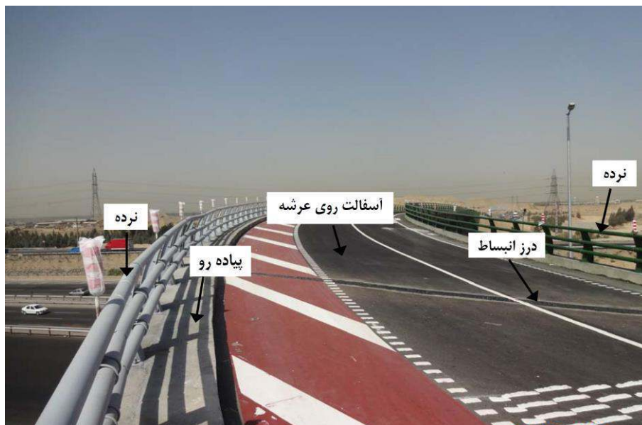
شکل ۱: نمایش اعضای متداول پل از روی عرشه
