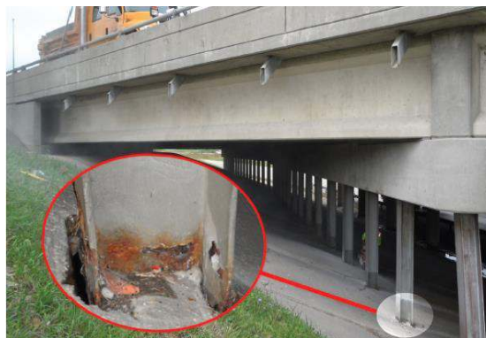
پای چند ستون فلزی دچار خوردگی و اعوجاج شده است.
