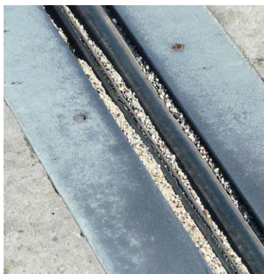
مقداری انسداد حرکت به سبب جمع شدن خاک و خاشاک در شکاف درز، بوجود آمده است.
