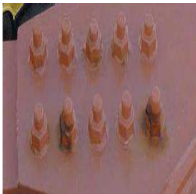
دو تا از پیچهای اتصال تیر دچار زنگ خوردگی شده است.
