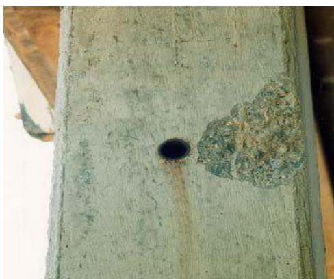
کنده شدن بتن به دلیل ضربه است. اما این آسیب عمیق نیست.
