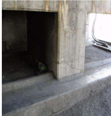
پوسته شدگی شوره زدگی و نمایان شدن آرماتور نشانگر اولویت تعمیر متوسط است. البته بتن دارای ترک نیز می باشد.
