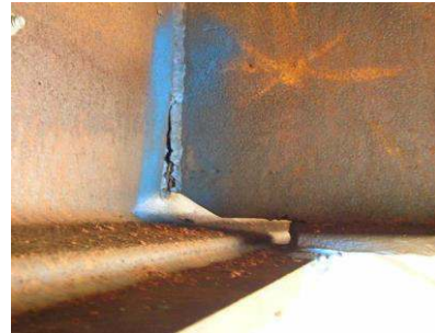
ترک قابل توجه در جوش دیده می‌شود. طول ترک بیشتر از ۲ سانتیمتر است. مقطع به صورت بالقوه قابلیت شکست دارد.
