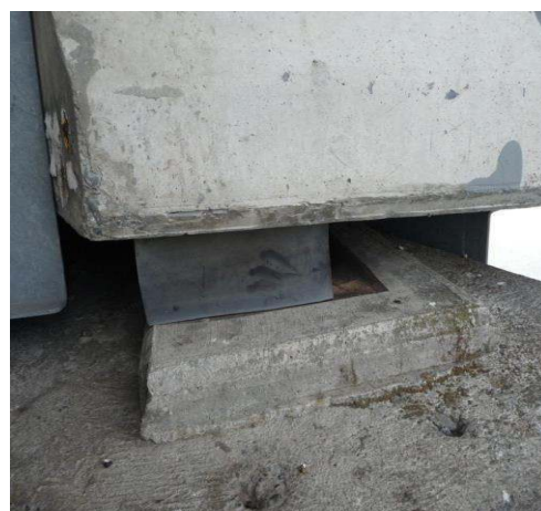
تکیه‌گاه از محل استقرار جابه‌جا شده است.
