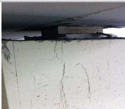
تنها یک ترک متوسط دیده می‌شود. فعال و پیش‌رونده بودن ترک باید بررسی گردد.
