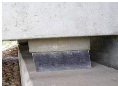
تکیه‌گاه الاستومریک مقداری تغییر شکل نشان میدهد اما شرایط خوبی دارد.
