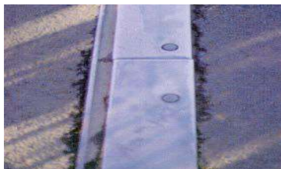
اجزاء فولادی دارای شرایط خوبی می‌باشند. آسفالت اطراف درز از بین رفته است.
