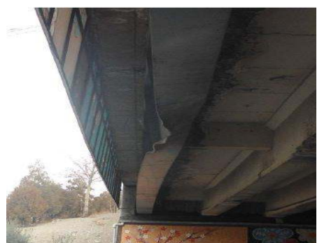
برخورد شدید با تیر باعث تغییر شکل و اعوجاج شده است.
