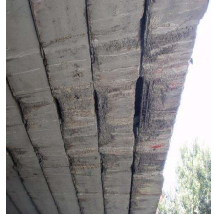
در چند تیر ابتدایی عرشه قسمتی از دال پوشش خود را از دست داده است و آرماتورها نمایان شده اند.
