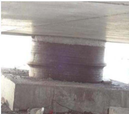
لاستیک تکیه‌گاه بیرون زده است و باید سریعاً تعویض شود.
