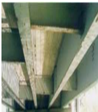
آثار زنگ زدگی در تیرها و دیافراگمها عرشه دیده می شود.
