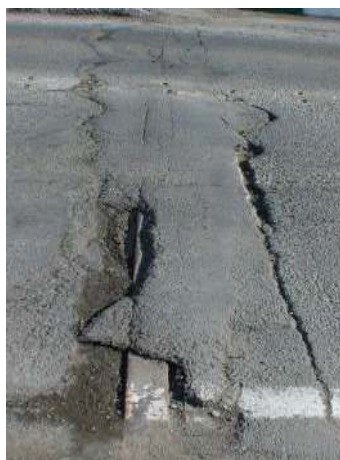
درز بطور کامل با آسفالت پر شده است و کارآیی ندارد.
