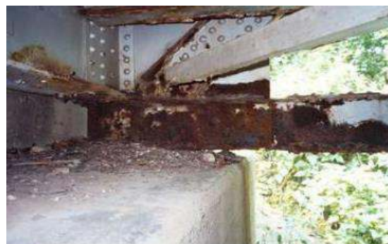
تیر اصلی و اجزای فلزی عرشه در محل اتصال به شدت خورده شده‌اند. مقطع تیر اصلی کاهش یافته است.
