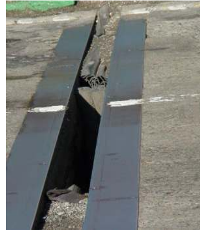
لاستیک درز کنده شده است و باعث اختلال در ترافیک عبوری شده است.
