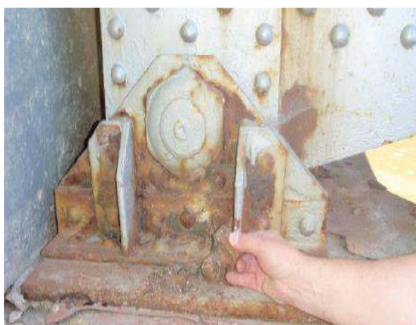
تکیه‌گاه خوردگی شدید دارد و یکی از بولت‌ها شکسته است.
