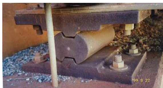
بطور کلی با وجود خوردگی جزئی یا زنگ زدگی اتصالات، عضو دارای شرایط خوبی است. نشیمنگاه باید تمیز شود.
