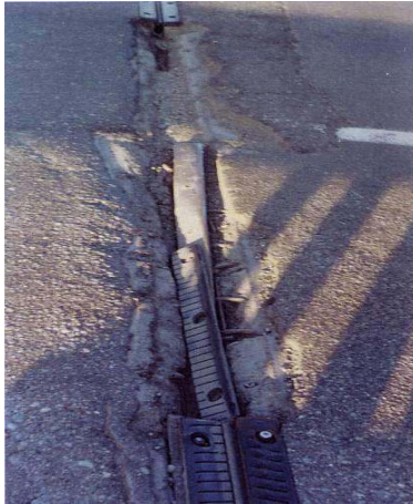
بخش اعظم درز بطور کامل (ورق رویه، لاستیک درز و بتن اطراف درز) کنده شده و از بین رفته است و ایجاد چاله نموده است.
