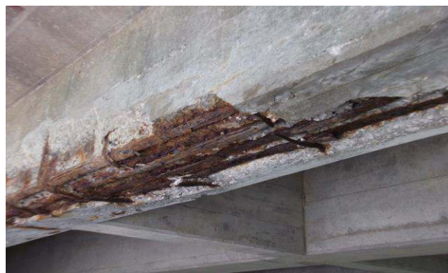
شکل ۶: خوردگی و نمایان شدن آرماتورها
