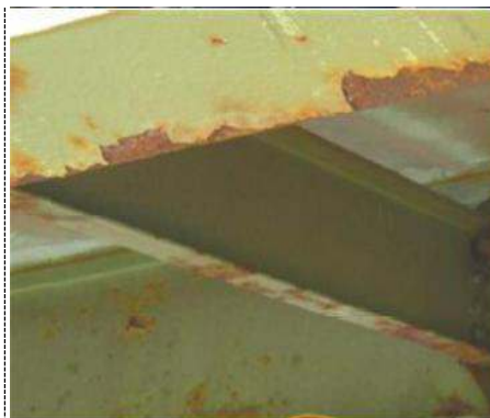
بال پایین و جان تیرها دچار زنگ زدگی و کمی خوردگی شده است.
