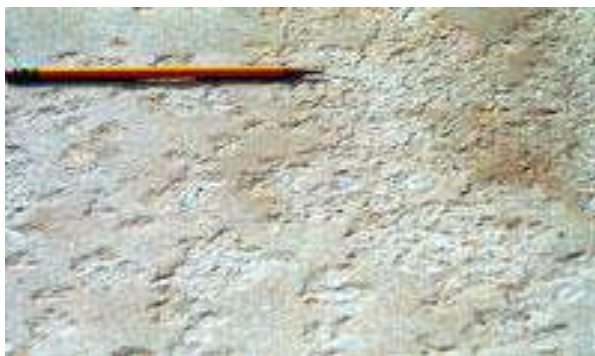
شکل ۱: پوسته شدن بتن
