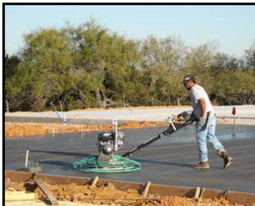
شکل ۵-۶- برداخت سطحی کف با ماله‌ی پروانه‌ای
