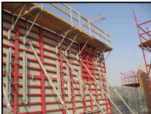
شکل ۱-۵- سیستم قالب‌بندی دیوار بتنی بلند
