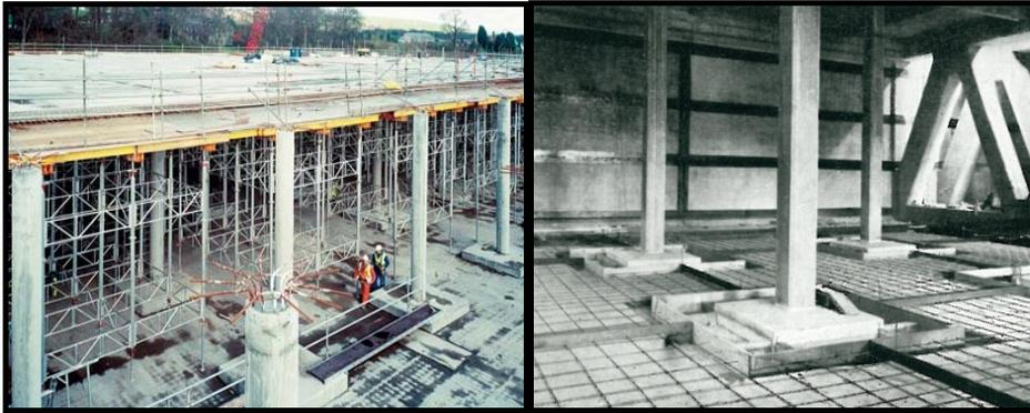
ب- سیستم پی منفرد در زیر ستون‌ها و پی نواری در زیر دیوارها و اجرای یک لایه بتن گسترده جهت آببندی
