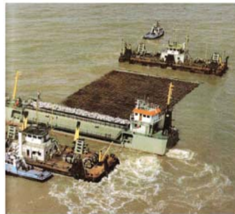
شکل (۳-۷) نصب ژئوسینتتیک‌ها در بستر دریا توسط بارج [۲۰-۲۱]
